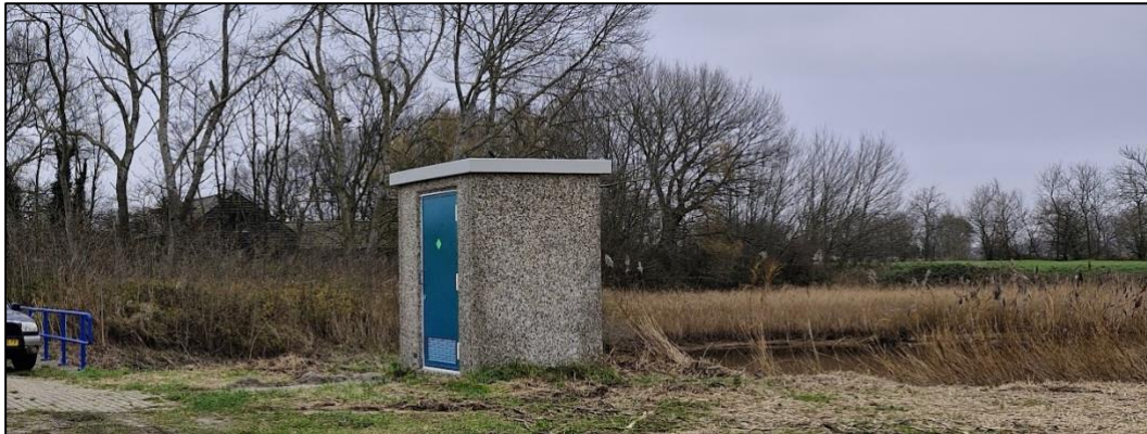
Figuur 3.3 Het reeds bestaande trafohuisje in het plangebied. Deze biedt geen mogelijkheden voor verblijfplaatsen van vleermuizen.
