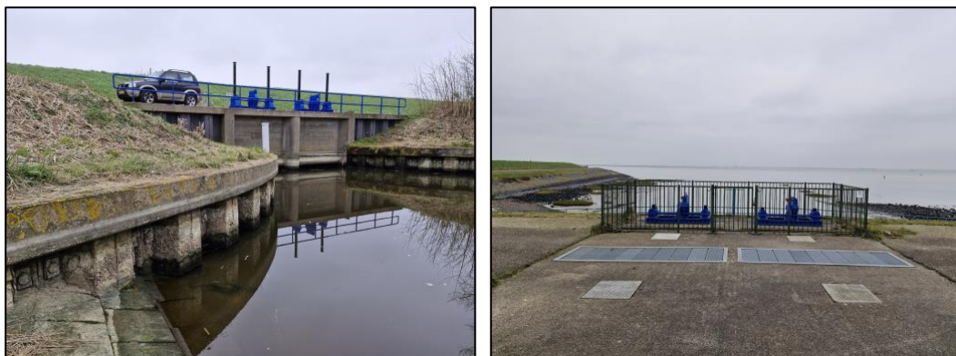
Figuur 2.2 en 2.3 Impressie van het plangebied met links de afwateringssluiss binnendijs. Rechts de installatie buitendijs met de Westerschelde op de achtergrond.
