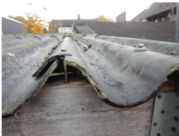
De golfplaten op het afdak zijn niet asbestverdacht
