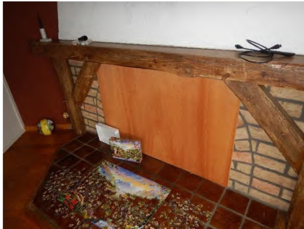
De schoorsteen is niet beoordeeld
