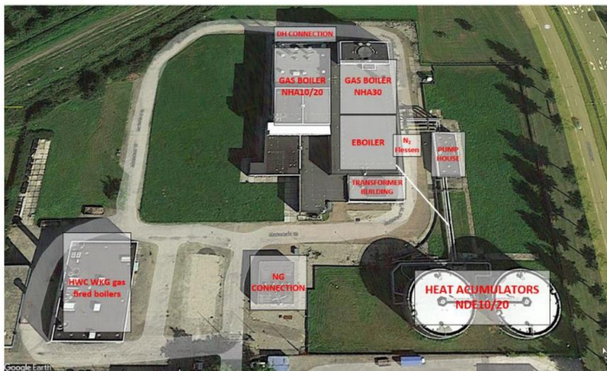
Figuur 2-2: Situering diverse installaties waaronder nieuwe E-boiler en transformator gebouw
