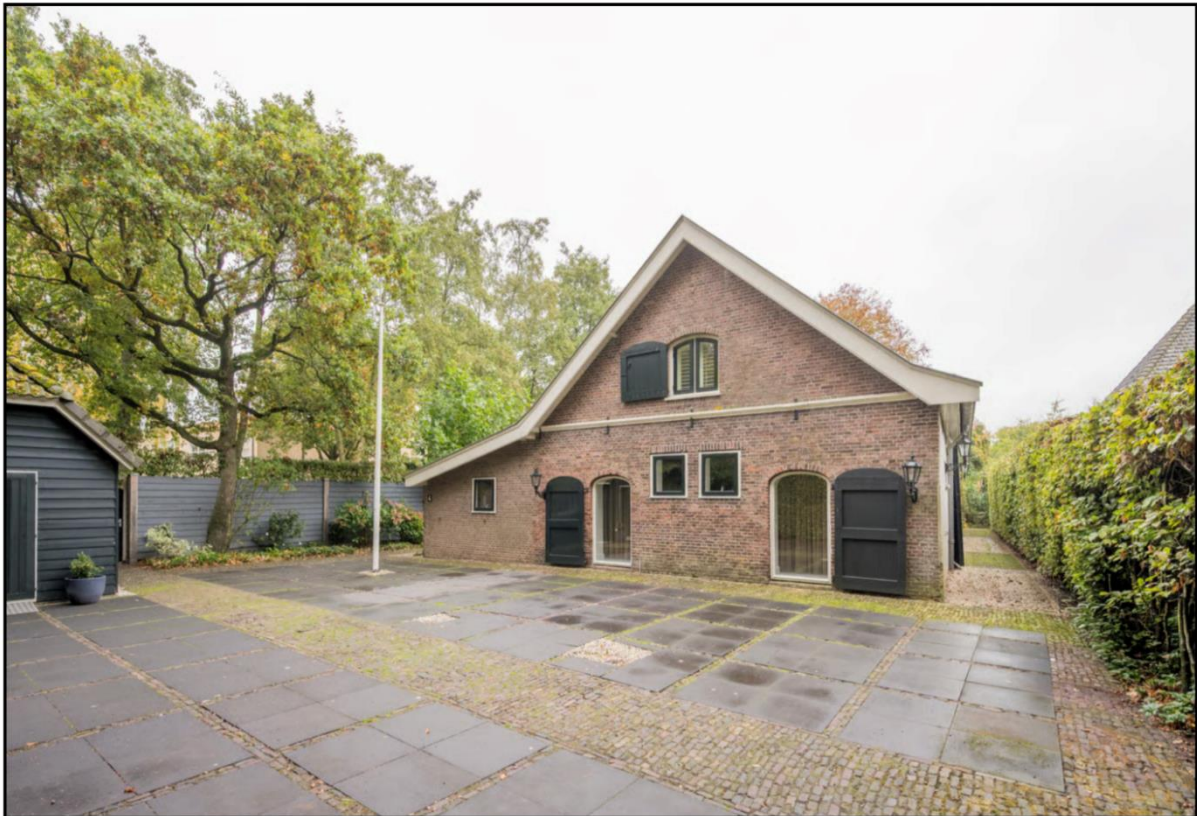
Afbeelding 2.2 Straatbeeld projectgebied, gezien vanaf de voorzijde (Bron: Google Streetview)
