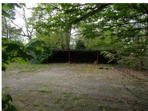
Aanzicht aanwezige fietsenstalling;
