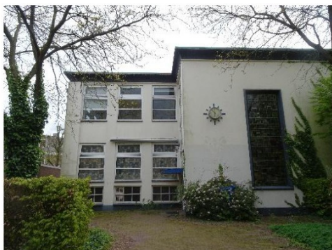
Aanzicht voorzijde schoolpand;
