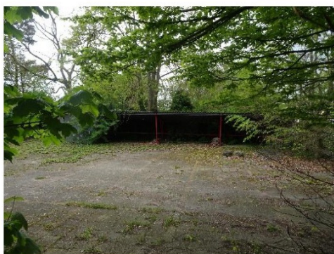
Aanzicht aanwezige fietsenstalling;
