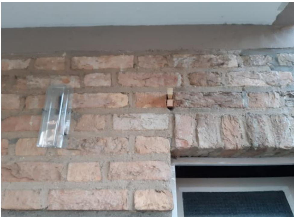
Figuur 10: Exclusion flap en dichtgezette open stootvoeg
