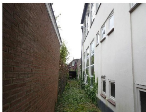
Figuur 4: Aanzicht steeg ten westen van het schoolpand;
