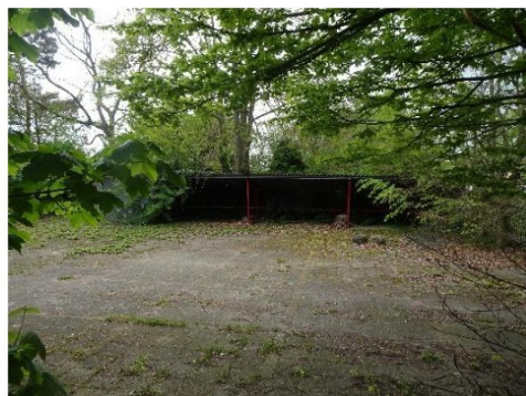
Figuur 5: Aanzicht aanwezige fietsenstalling;
