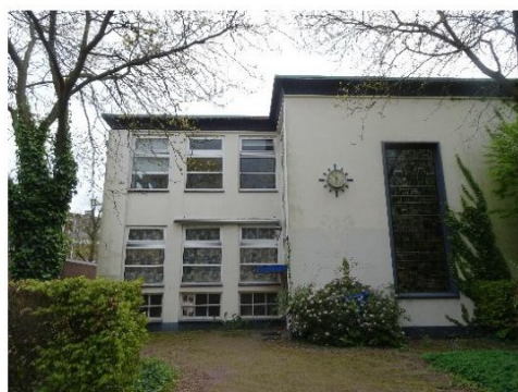
Figuur 3: Aanzicht voorzijde schoolpand;
