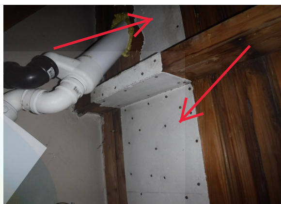
Plaatjes tegen dakbeschot
