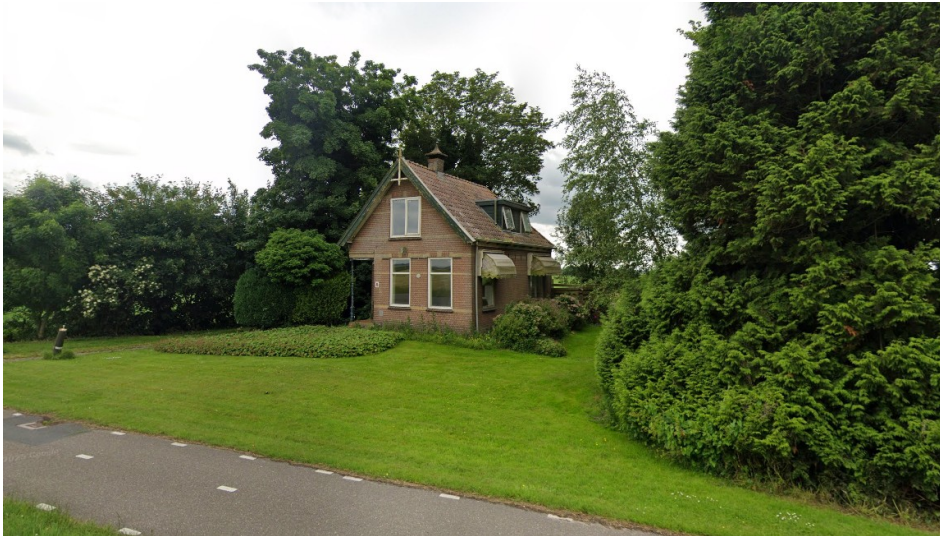
Figuur 2.1 Huidige situatie (bron: Google Street View)
