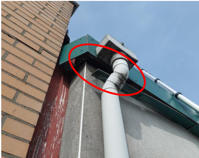
Figuur 4 Opening bij het boeiboord aan de oostkant van deel 4
