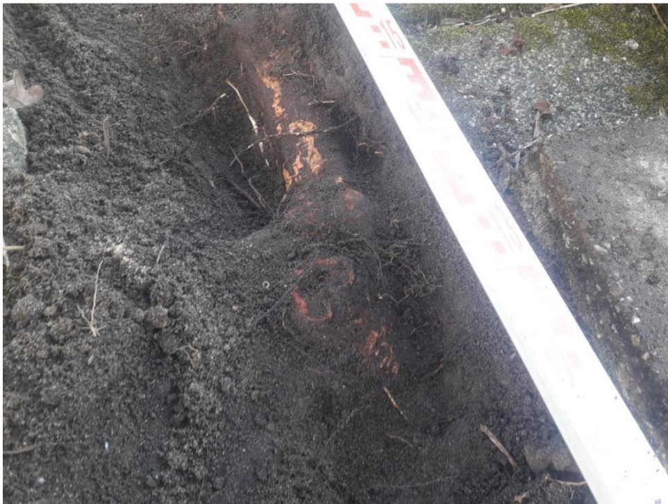
Figuur 3.6 Omvangrijke gestelwortel op 1 meter afstand van te verwijderen bebouwing
