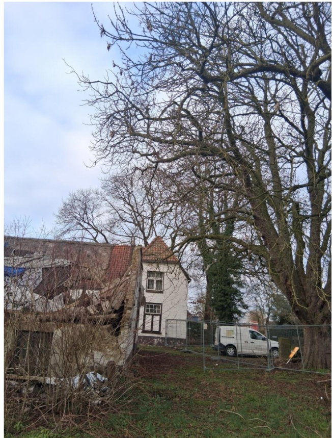
Figuur 5.3 Overhangende takken boom 4 en 5
