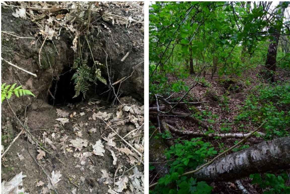
Figuur 11. Eén van de pijpen van de oude dassenburcht die aanwezig is in het bos aan de westzijde van het onderzoeksgebied. En een overzichtsfoto van verschillende (ingestorte) pijpen.
