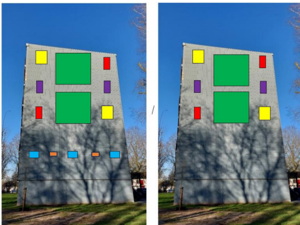
Figuur 2. Overzicht plaatsing twee keer vier geschakelde VMPW2 kasten (groen) aan de oostelijke en westelijke kopse gevels van clusters 1316 en 1317.
