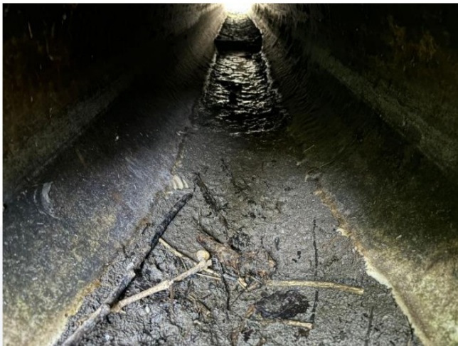
Figuur: 4.4.7: Duiker in zuidwesthoek van het plangebied.
