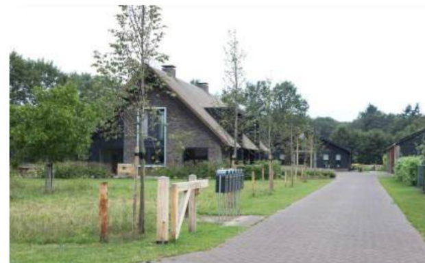
Onverschheid tussen bestaande woning en nieuwbouw
