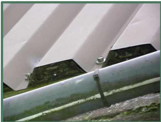
Foto 35: Damwand element voorzien van isolatie.
