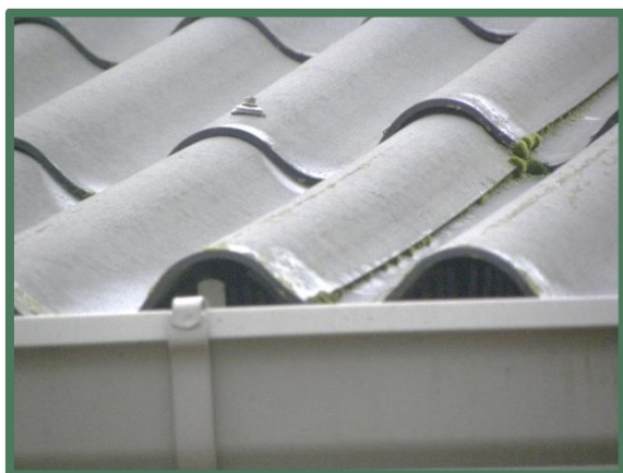
Foto 27: Dak stal 6 voorzien van vogelschroot.
