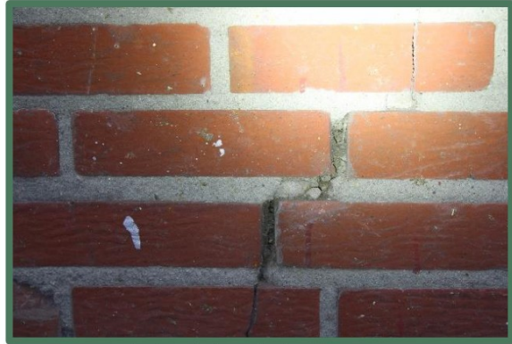
Foto 32: Voegschade stal niet geheel tot spouw.
