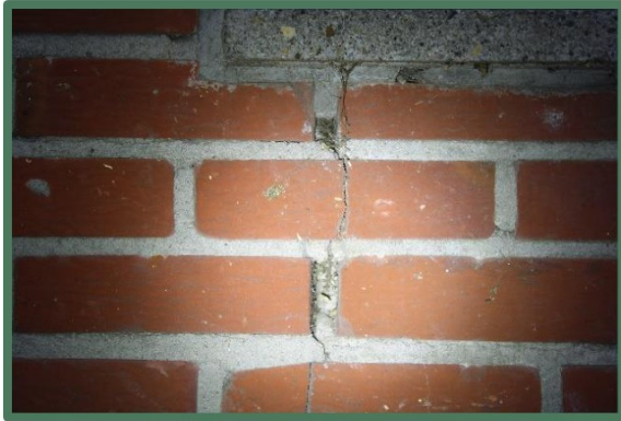
Foto 31: Voegschade stal niet geheel tot spouw.
