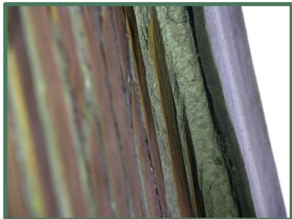
Foto 36: Ruimte tussen wand en windveer voorzien van cement.
