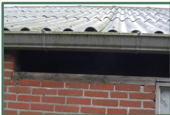
Foto 29: Spouw afgesloten met houten lat.
