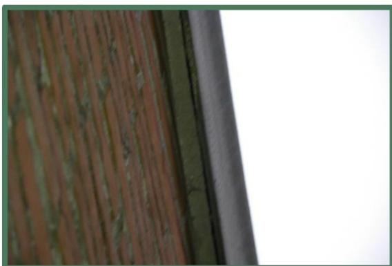
Foto 37: Ruimte tussen wand en windveer voorzien van cement.
