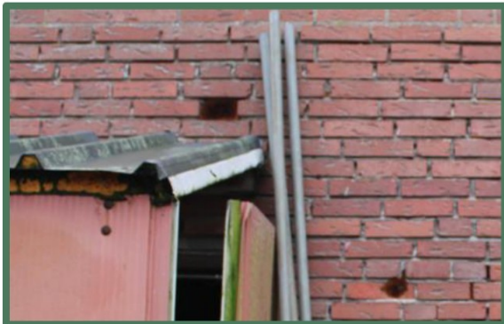
Foto 33: Gat in buitengevel stal opgevuld met bouwschuim.
