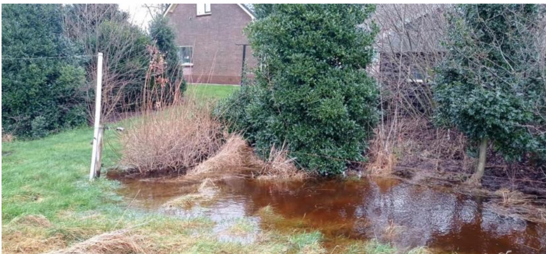
Foto 4: Inundatie afvoerloze greppel achter kippenhok
