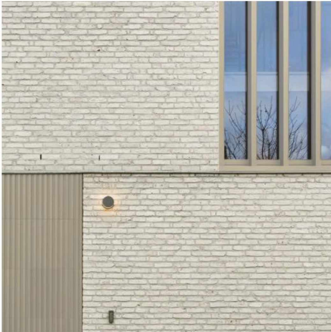
Halfsteensverband baksteen metselwerk, dat ook op afrondingen kan worden toegepast - BG
