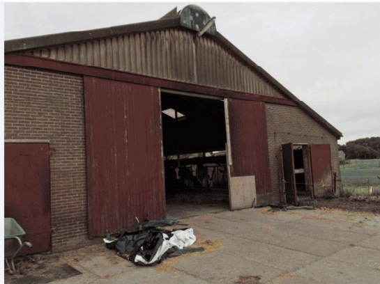
Achtergevel stal G
