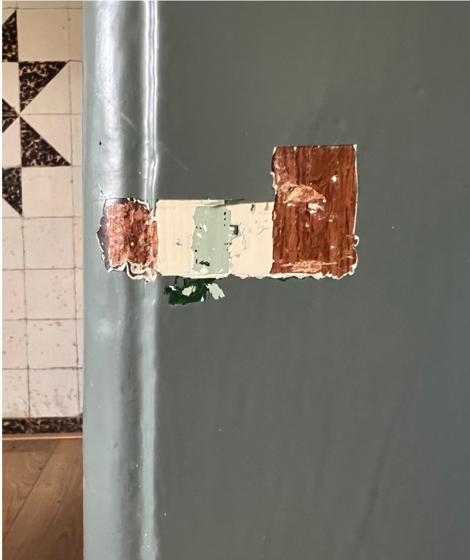
Afbeelding 86. Detail verflagen schouw in de woonkamer, ruimte 0.5. De schouw was volledig gehout, de latere lagen variëren tussen lichte en donker groene lagen, beige en witte lagen en ook een bordeaux verflaag.
