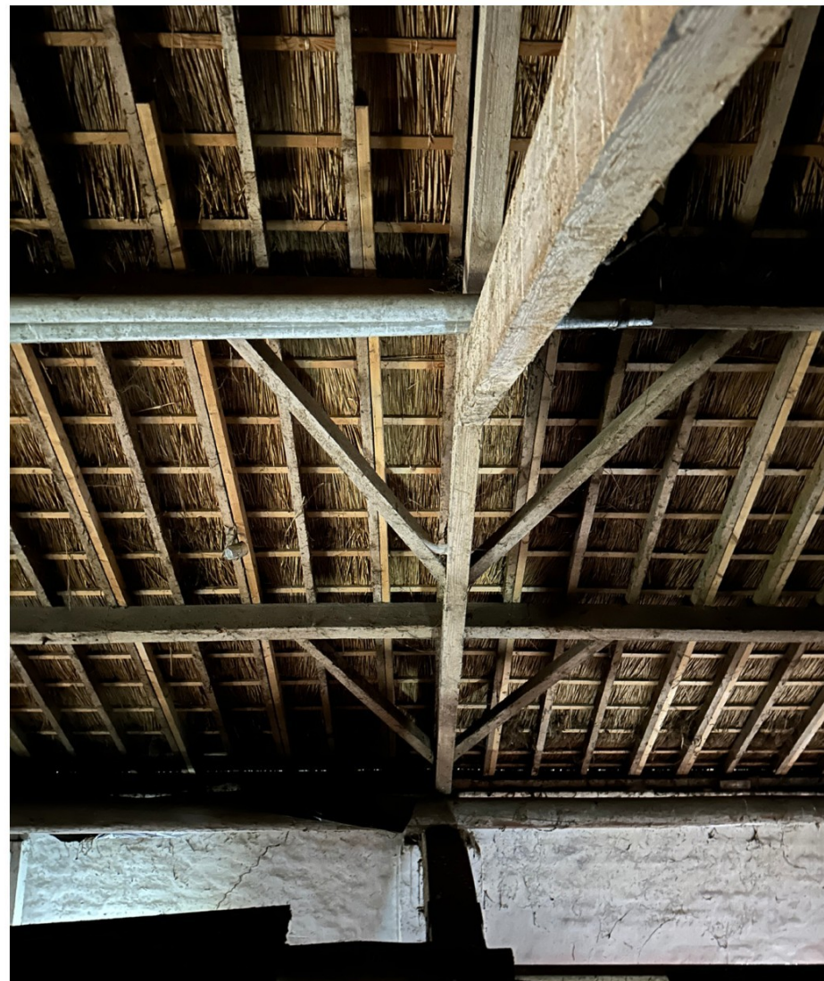
Afbeelding 94. Dakspant Stal 2. De windveren verbinden het spantbeen met de gordingen. De elementen zijn met gespijkerd. De trekplaat is gepend.
