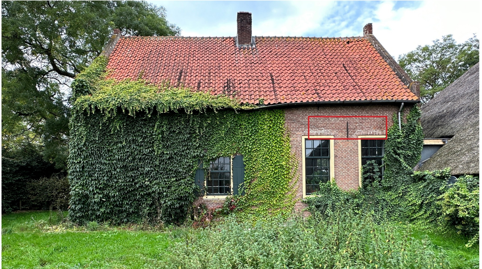
Afbeelding 61. Achtergevel van de woning die verbonden is met Stal 1. Grotendeels bedekt met klimplanten waardoor de helft van de gevel minder goed zichtbaar is. De grote ramen aan de rechterkant van de gevel blijken van een latere fase te dateren; mogelijk zijn de ramen verbreed en verhoogd ten opzichte van de oorspronkelijke vensters. Boven deze ramen zijn er ook recente mortel reparaties.
