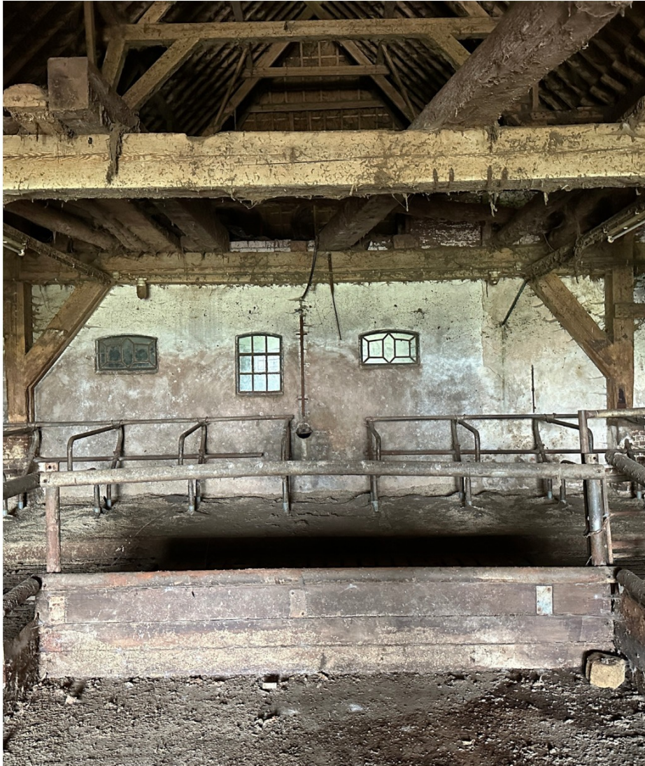
Afbeelding 62. Interieur Stal 1, die als koeienstal werd gebruikt. Ruimte 0.15. De huidige betonnen vloer werd in pas 1983 gebouwd om gebouw weer te laten voldoen aan de nieuwe eisen.
