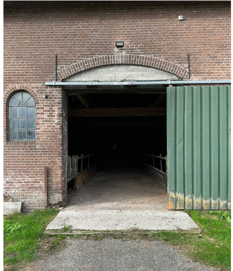
Afbeelding 47. Grote poort in Stal 1. Deze poort is van een latere fase en vervangt volgens de tekeningen een houten deur.
