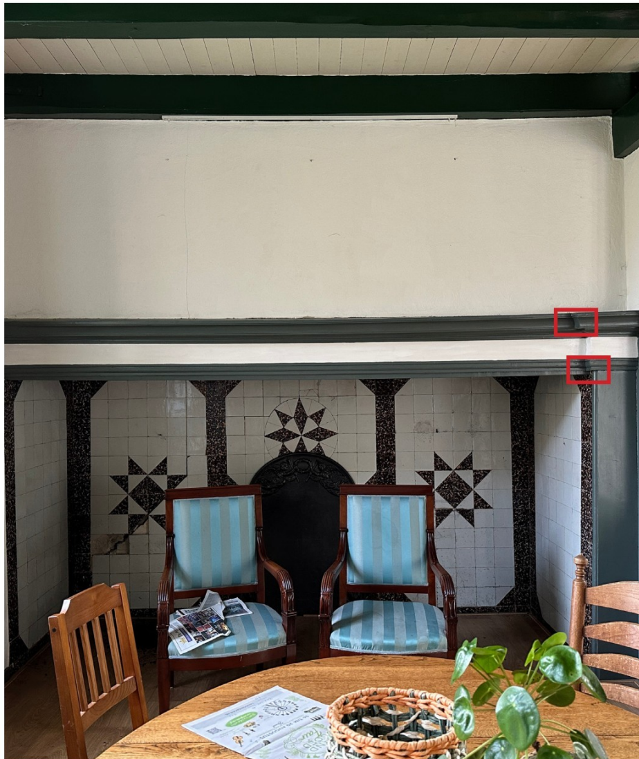
Afbeelding 84. Schouw in ruimte 0.05, de woonkamer met originele tegels en ijzeren haardplaat. Details van de afwerking van de schouw, afbeelding 80a en 80b (aangeduid op afbeelding).
