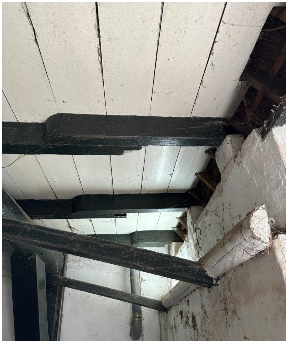
Afbeelding 82. Aansluiting kapconstructie met de voorgevel. Hier gebeurt van alles dat niet direct verklaarbaar is. Het meest waarschijnlijk is dat de gevel reeds bestond (midden 18e-eeuws) toen de kapconstructie werd geplaatst (einde 19e eeuw). Toen later (in de 20e eeuw – vooralsnog 1983, maar vermoedelijk al veel eerder) een vloer werd geplaatst, werden balken van elders hergebruikt. Aangezien deze te kort waren, werden deze aangelegd.
