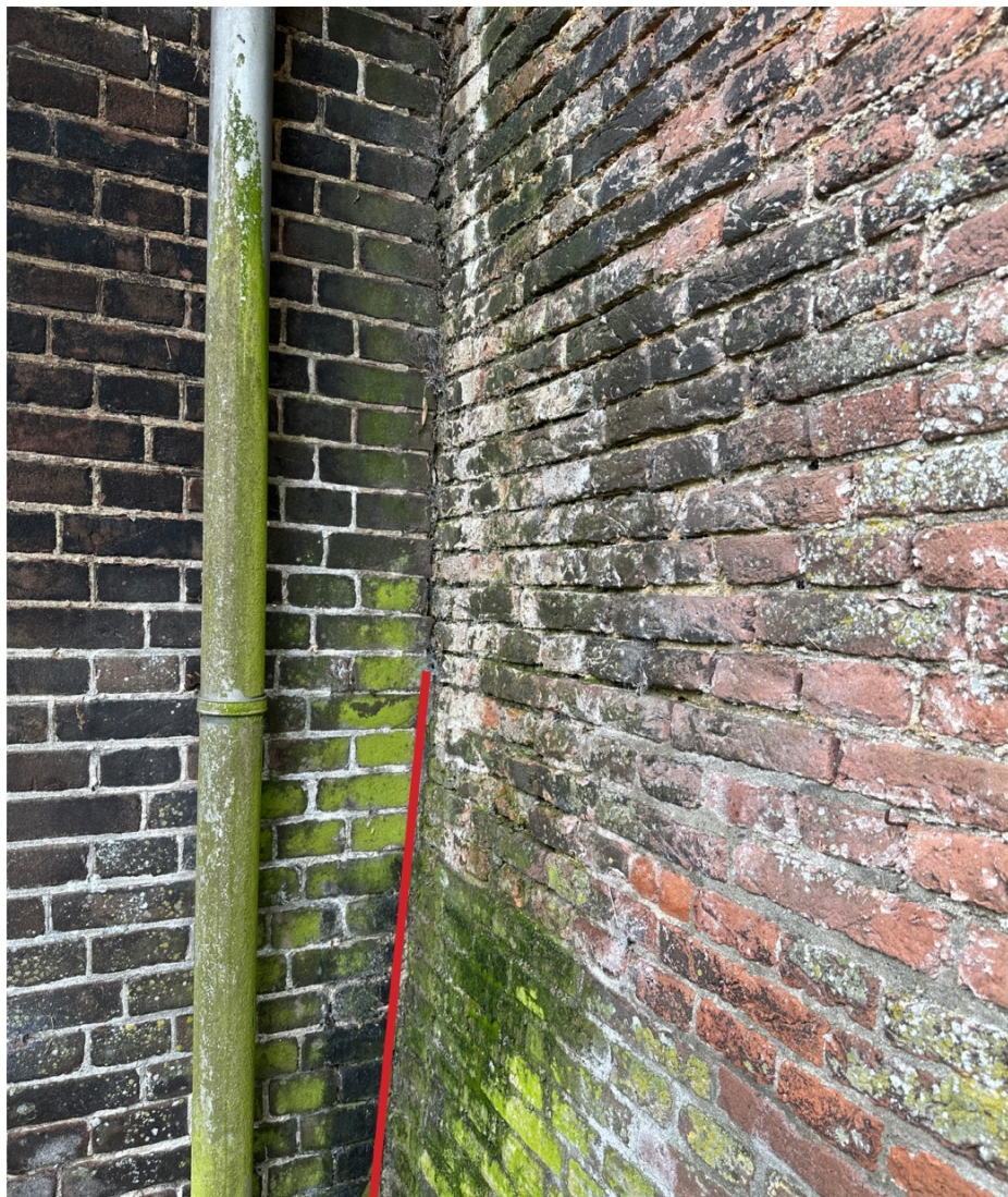
Afbeelding 53. Hoek detail tussen het uitstekend gedeelte van de Linker zijgevel Stal 1. Wat hier opmerkelijk is, is de naar beneden uitlopende schuine van de muur (zoals aangeduid op de afbeelding). Men kan hier ook een duidelijk de koude naad zien tussen de twee delen van Stal 1. Het oudste gedeelte dateert uit de 18de eeuw.
