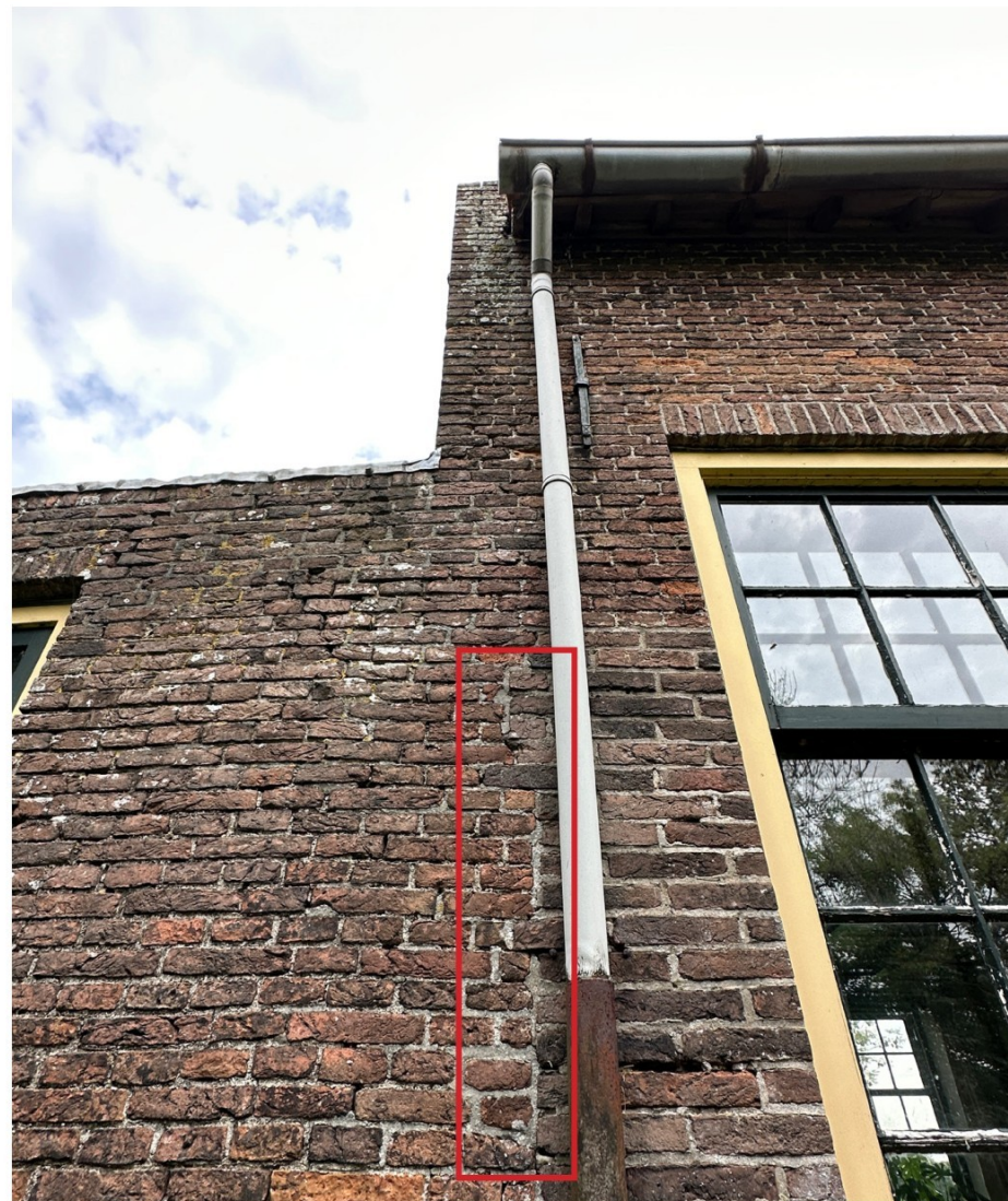
Afbeelding 58. Aansluiting van Woning op Schuur 1, zichtbare verschillen in bakstenen, waar een opening dichtgezet is (vermoedelijk een deuropening). Boven het rode kader loopt het metselwerk wel door en lijkt er dus geen sprake van een bouwphase.
