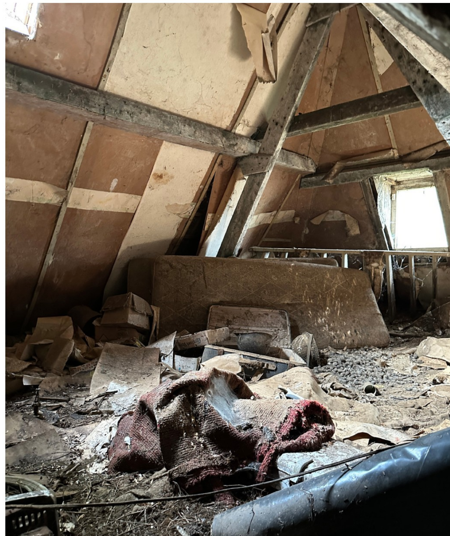
Afbeelding 96. Bergzolder, ruimte 1.4, deze ruimte bevindt zich boven ruimte 0.12. De ruimte is vanwege de slechte staat van de vloerconstructie niet te betreden. Het spant is zeer licht gedimensioneerd.
