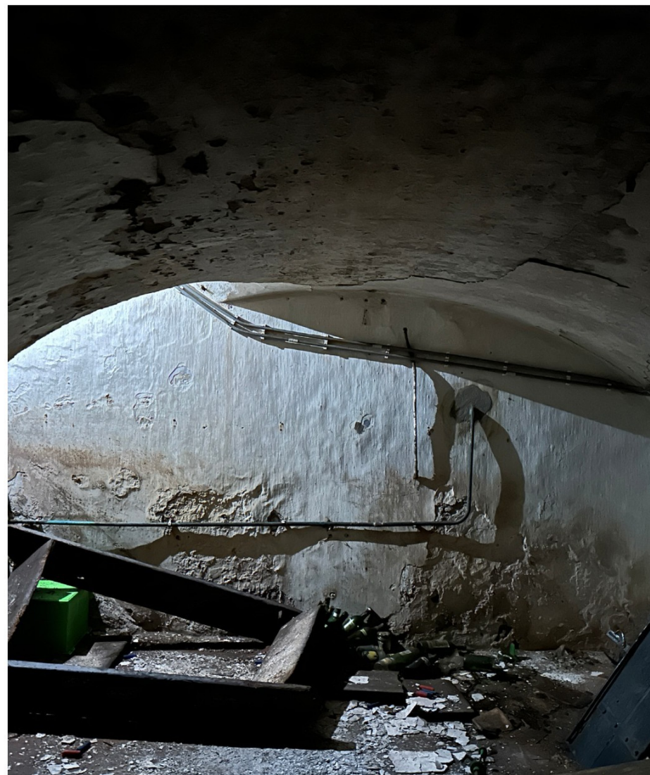
Afbeelding 39. Ruimte -0.1. De trap die ingang verleend aan de kelder is ingestort, de trap leidt naar de bijkeuken, ruimte 0.13.
