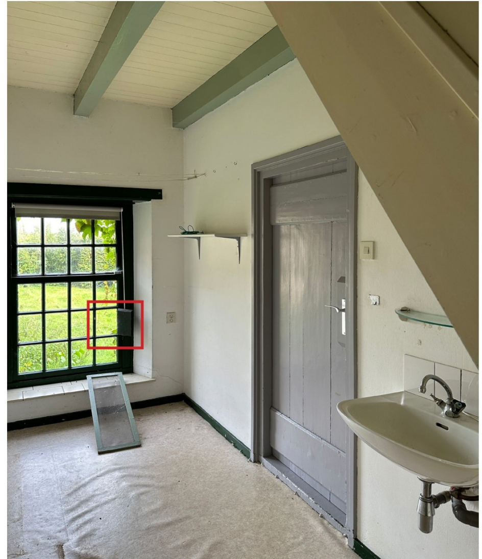
Afbeelding 89. Ruimte 0.04, ruimte onder de trap. Deze ruimte lijkt nog een origineel raam te hebben. Ook is het ventilatie luikje in het raam merkwaardig. De opgeklampte houten deur zou uit de 18de of 19 eeuw kunnen dateren.
