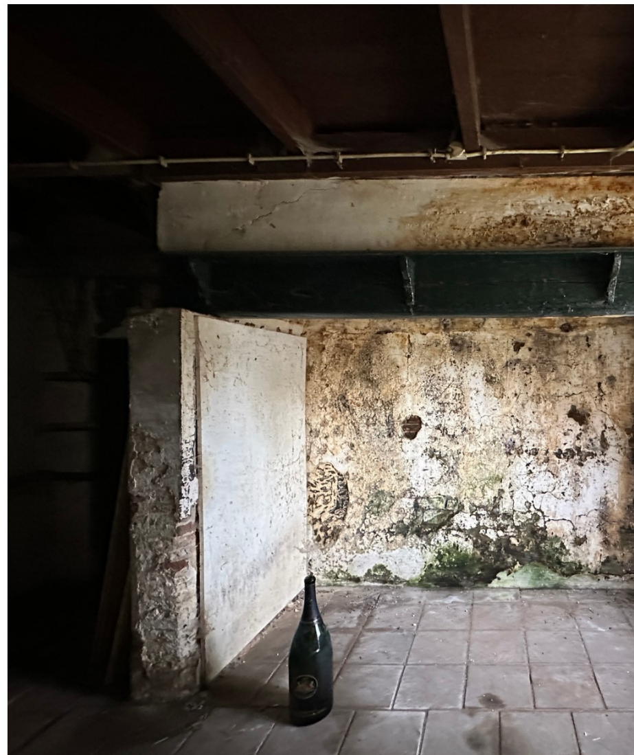
Afbeelding 73. Schouw in bijkeuken, ruimte 0.13. De schouw is samengesteld uit een houten schouwlijst ondersteund door een gepleisterde bakstenen wand.
