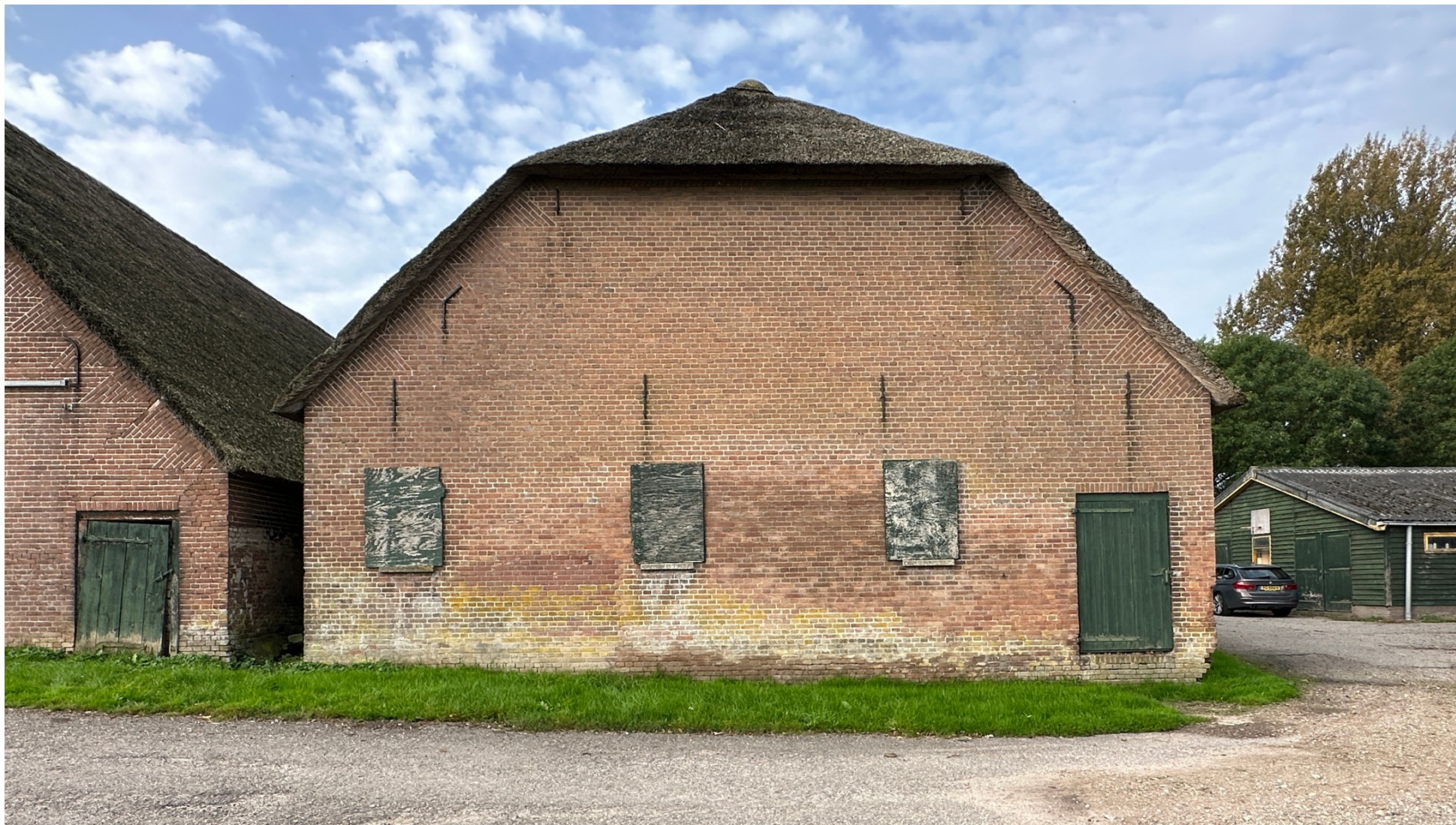
Afbeelding 45. De achtergevel van Stal 2 is vrijwel geheel on oorspronkelijke staat. Tussen de linker vensters – die dichtgezet zijn met plaatmateriaal – heeft wel een grote sparing gezeten die weer dichtgezet is.
