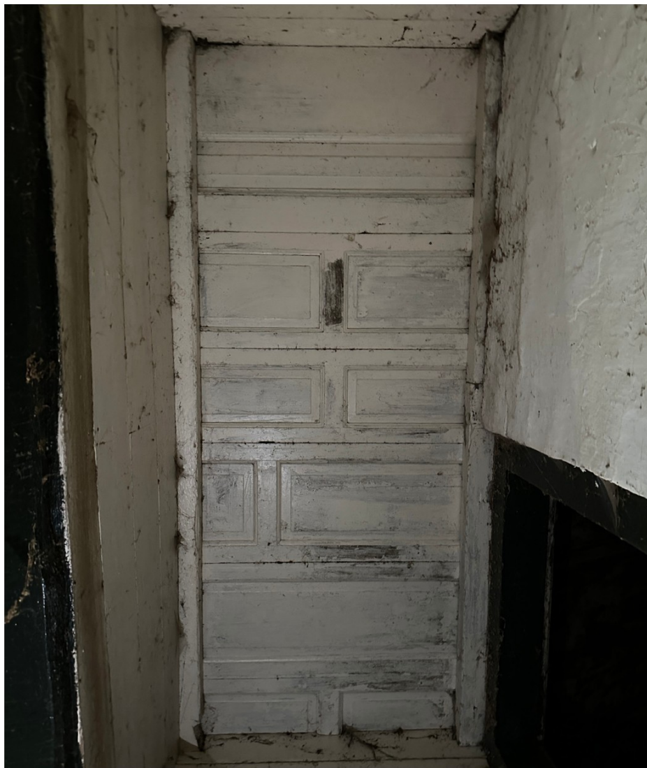
Afbeelding 78. Boven de deur van ruimte 0.13 naar 0.10, is een plafond afwerking die bestaat uit hergebruikte houten luiken.
