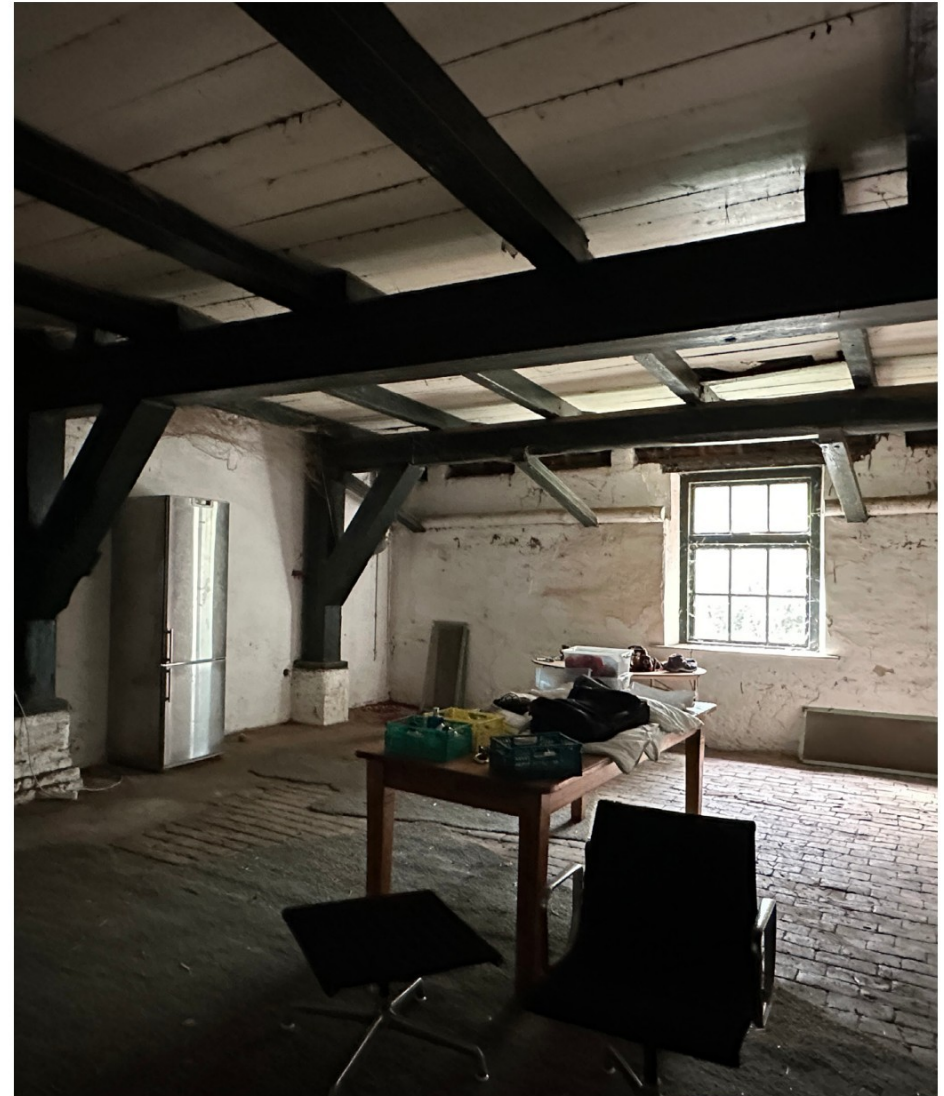
Afbeelding 77. Ruimte 0.10, de wand die zich achter de kolommen bevindt is in een latere fase gebouwd (1983) om ruimte te maken voor de keuken. De vloer is samengesteld uit estrikken. Dit zou een oorspronkelijke vloerafwerking van de gangpaden geweest kunnen zijn die in de stal verder verwijderd is.
