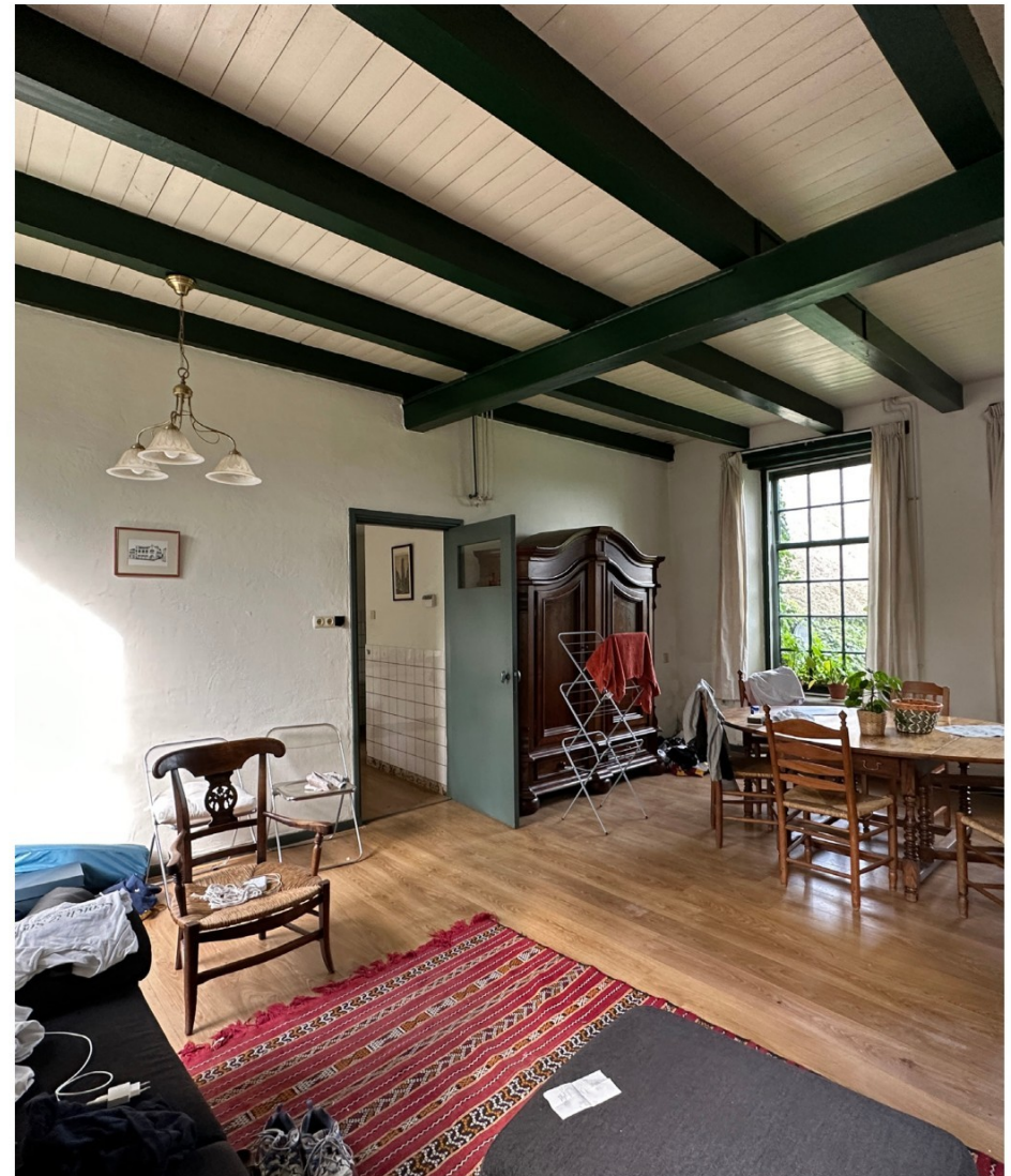
Afbeelding 85. Ruimte 0.05, de deur leidt naar ruimte 0.06. De vloerbekleding (laminaat) van de woonkamer is van recente datum. Het vloerpeil blijkt verhoogd te zijn ten opzichte van de oorspronkelijke hoogte van de kamer. De ramen aan de rechter kan zijn ook van een latere fase.
