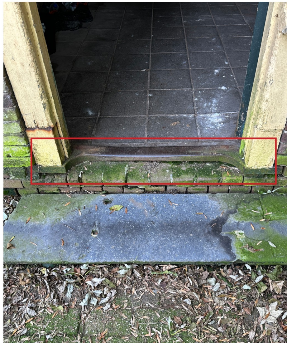
Afbeelding 56. Detail van deur met zijn bijzondere ijzeren dorpel in de linker zijgevel van Stal 1; deur K03.002.
