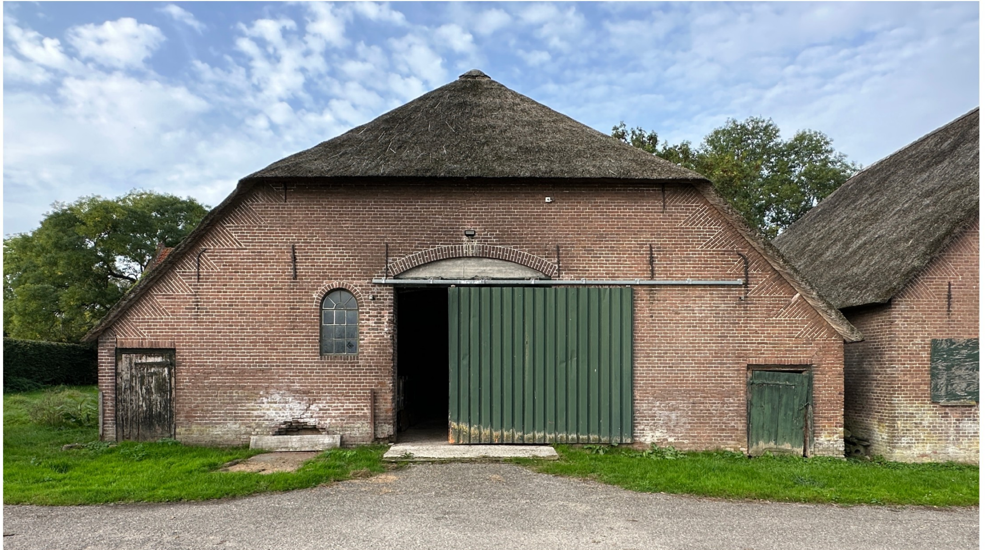
Afbeelding 44. Achtergevel van Schuur 1, in deze vorm uit 1893, maar met latere wijzigingen zoals de schuifdeur en links ervan de doorbraak voor een gierkelder. Dit is in 1983 uitgevoerd toen ook de breedte van doorgang van de poort werd vergroot. Bij deze ingreep werden ook de gietijzeren ramen naar buiten verplaatst.
