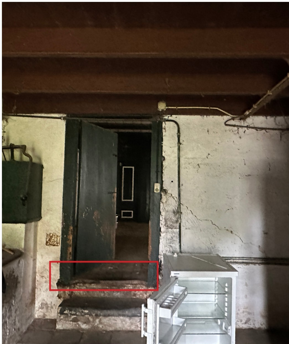
Afbeelding 74. Deur die ruimte 0.13 en 0.10 verbindt. Met hier ook een ijzeren dorpel, vergelijkbaar met afbeelding 54.
