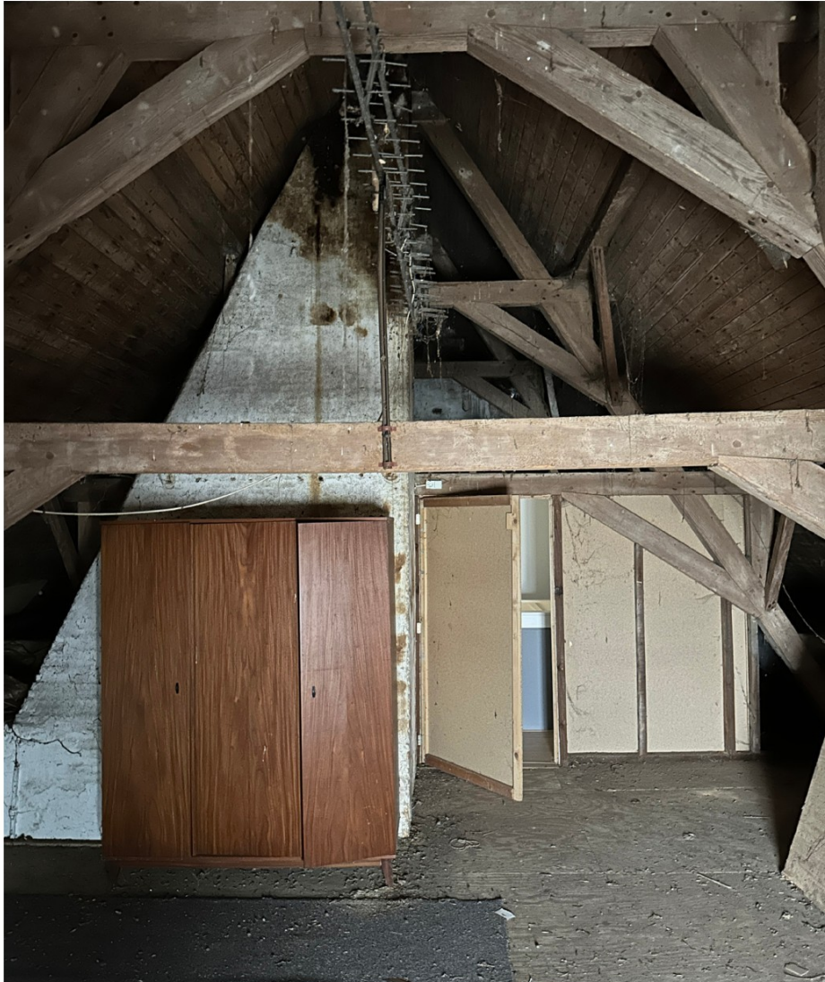
Afbeelding 99. Bergzolder, ruimte 1.03. Zolderruimte met gepleisterde bakstenen rookgasafvoer van de leefruimte. De zolder bestaat uit vier traveeën. Het dakspant heeft een vrij unieke compositie, zie detail Afbeelding 95.
