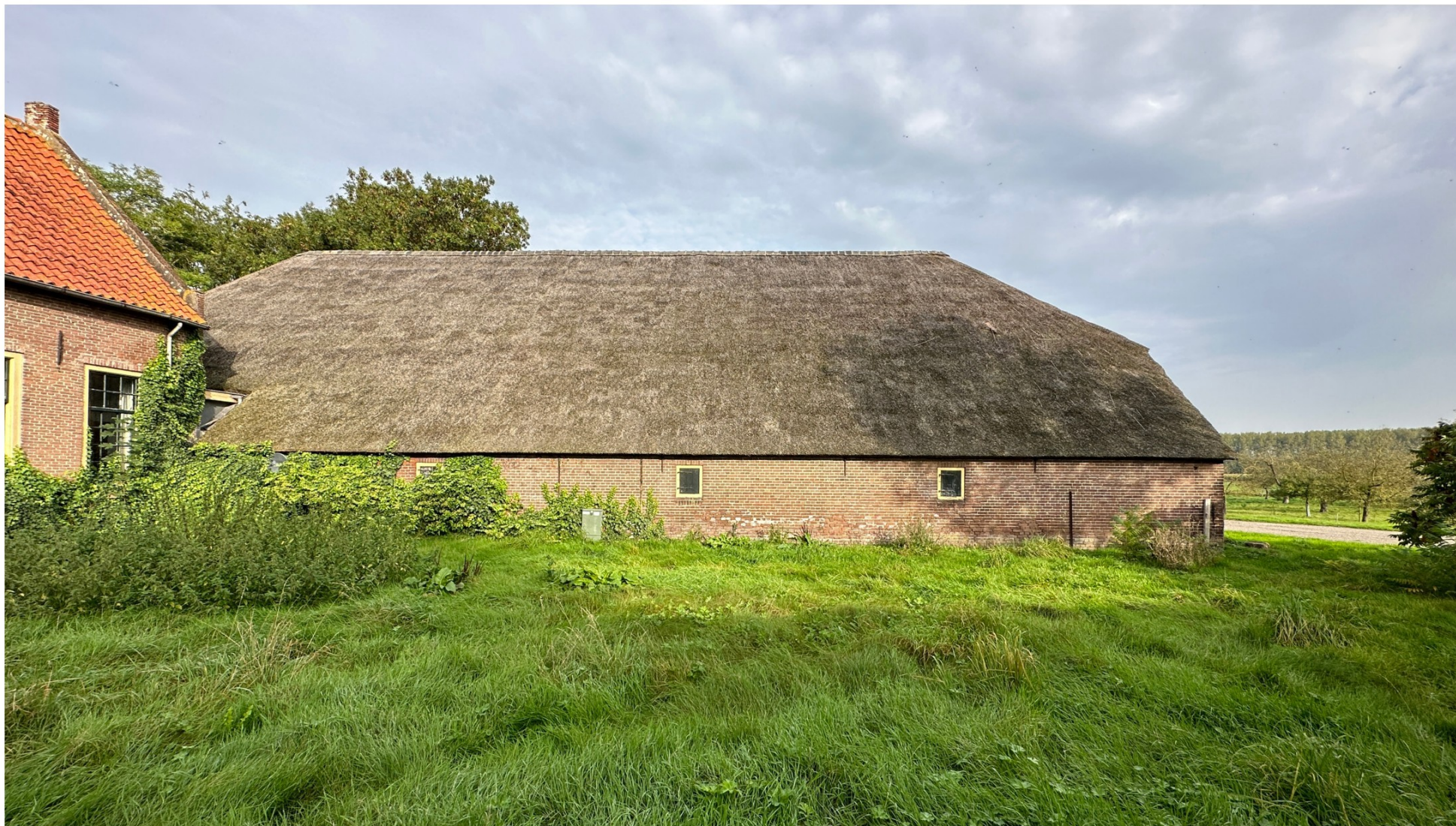
Afbeelding 48. De rechter zijgevel van Stal 1, gedeeltelijk bedekt met klimplanten waardoor een deel van de gevel niet zichtbaar is. Aan de onderkant van de wand is zoutuitbloei waarneembaar, maar de gevel is vrijwel authentiek (1893).
