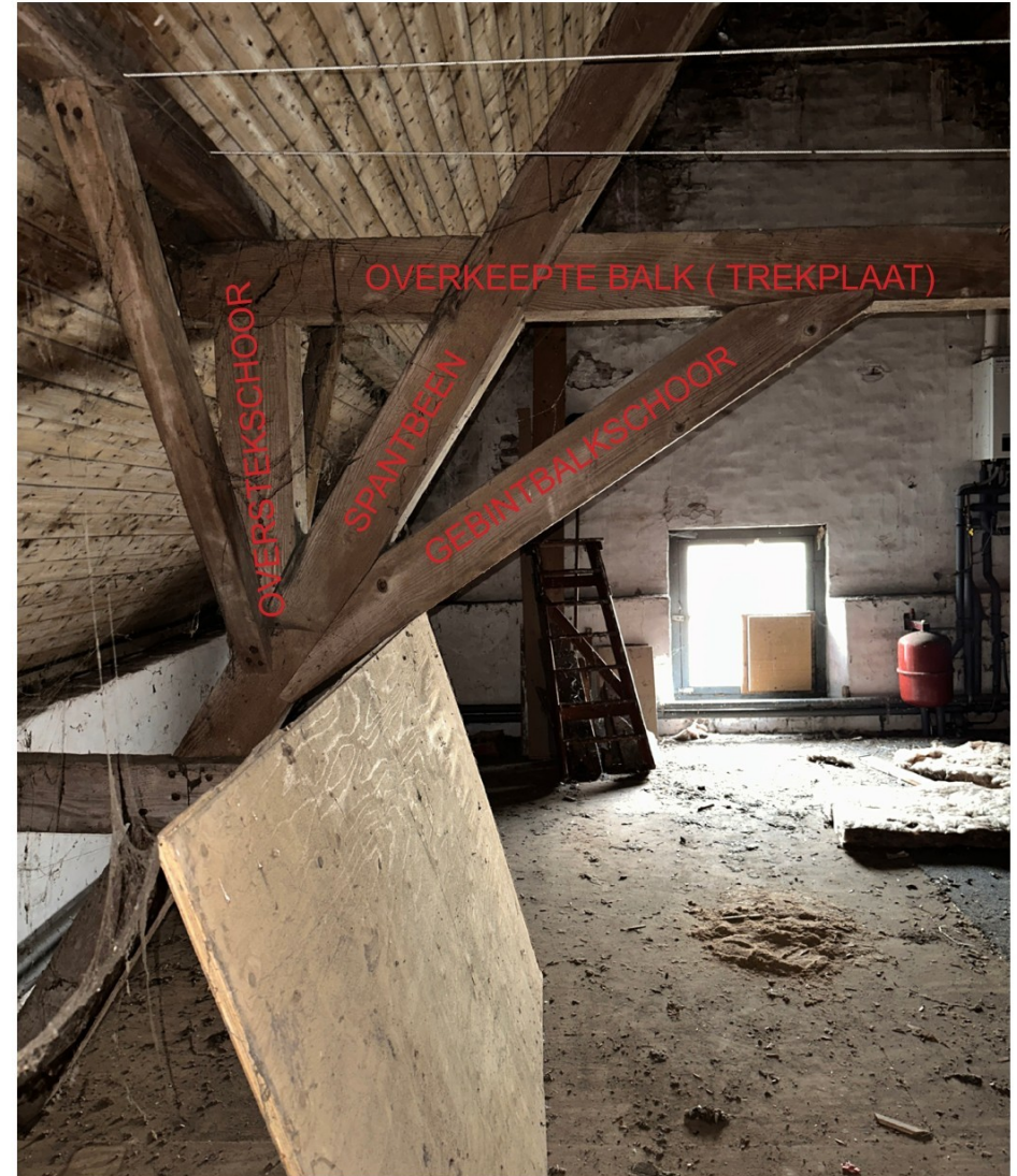
Afbeelding 100. Bergzolder, ruimte 1.2. De compositie van de gebintbalkschoor, overstekerschoor en spantbeen komt niet vaak voor. De ankerbalk en jukbeen zijn in een halfhoutse overkeping met elkaar verbonden.
