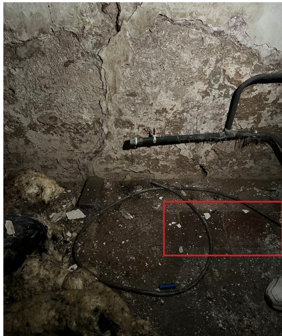
Afbeelding 37. Ruimte -0.1. De vloer van de kelder is samengesteld uit estrikken.
