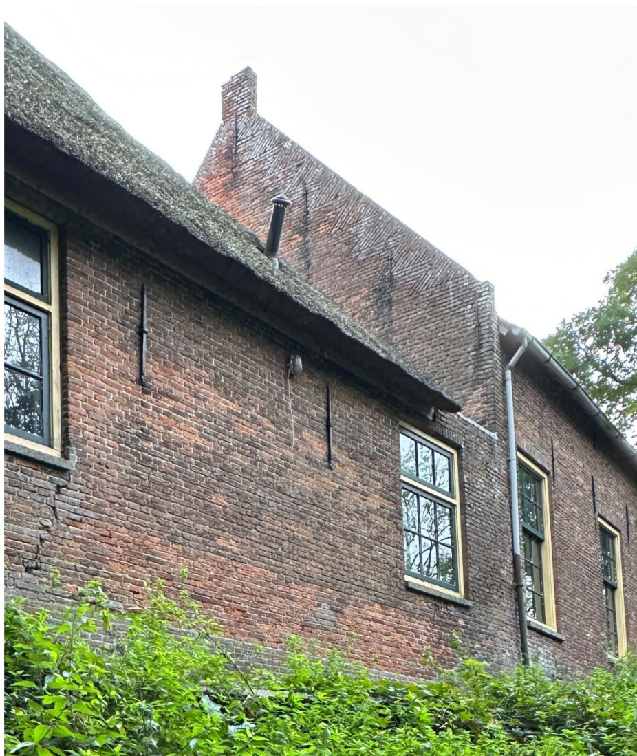
Afbeelding 57. Linker zijgevel van de woning die doorloopt tot boven het dak van Stal. Deze is in één keer tot stand gekomen. Opmerkelijk zijn de vlechtingen van de tuitgevel.
