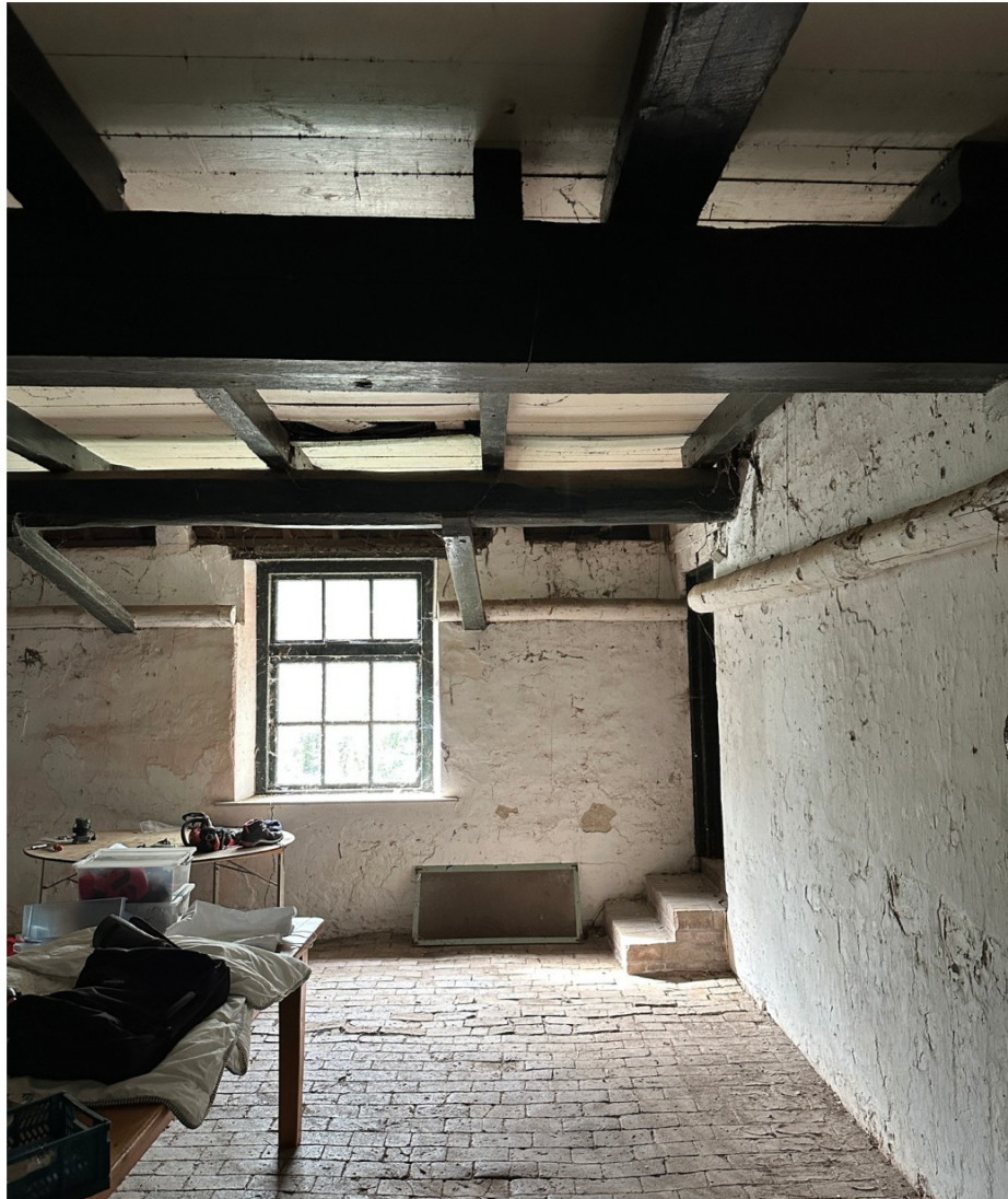
Afbeelding 76. Ruimte 0.10 de werkplaats, trapje verbindt deze ruimte met ruimte 0.12, de opkamer. De vloer is samengesteld uit estrikken.
