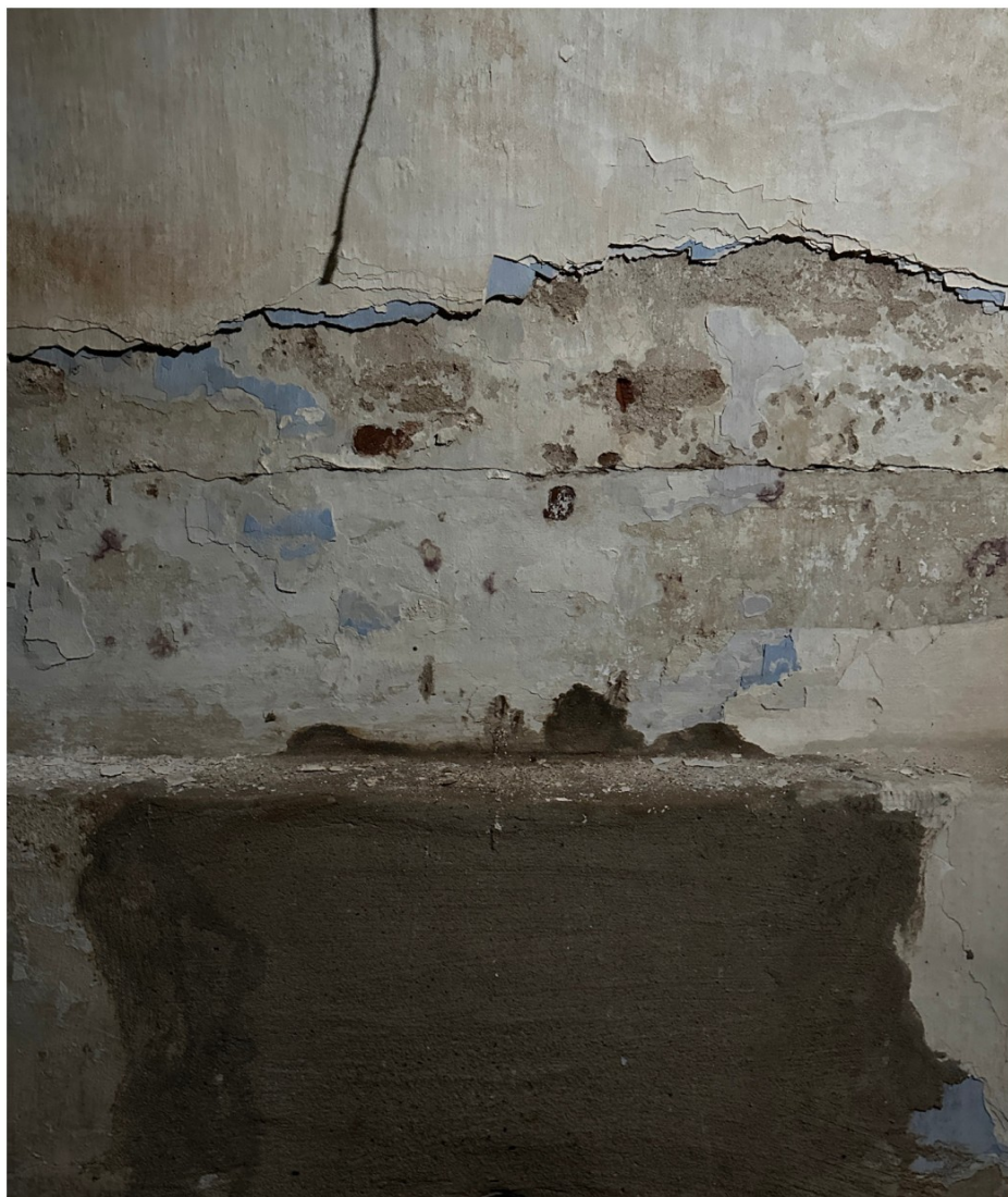
Afbeelding 38. Ruimte -0.1. Detail foto van de verschillende verflagen op het gewelf van de kelder. Merkwaardig is de middenblauw afwerking.
