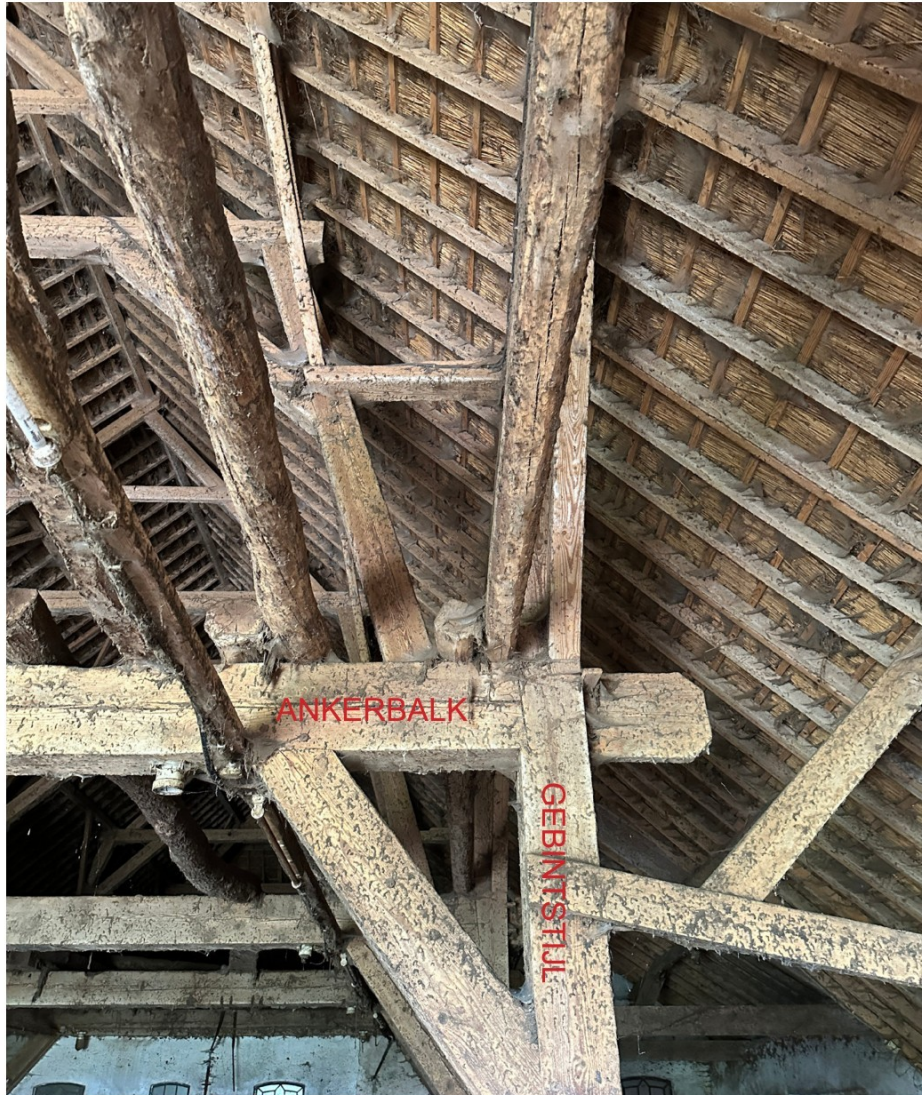
Afbeelding 64. Detail dakspant Stal 1. Hier ziet men mooi de verbinding van de ankerbalk met de gebintstijl door een doorstekende pen- en gatverbinding met wiggen. De gebintbalkschoor is met een gepende pen- en gatverbinding bevestigd aan de ankerbalk en gebintstijl
