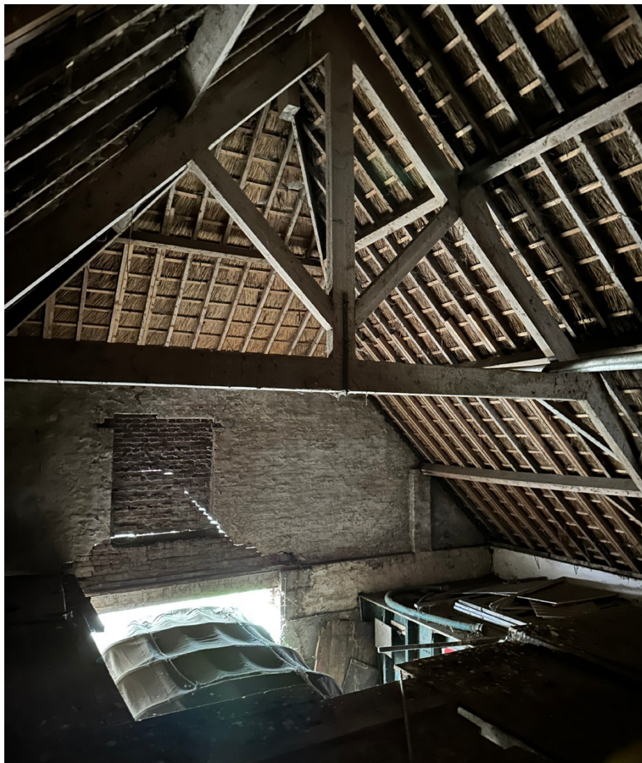
Afbeelding 93. Dakspant van stal 2. De dichtgemetselde raamopening en scheuren boven de poort opening zijn duidelijk zichtbaar.
