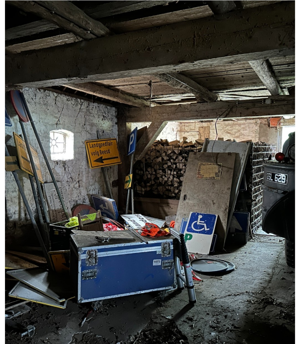
Afbeelding 69. Beeld interieur Stal 2. Op de tussenbalken ligt er een dwarse balklaag die de hergebruikte houten deuren en luiken ondersteunt om zo een vloer te creëren.
