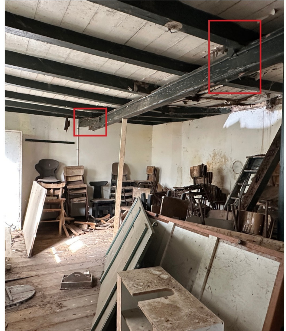
Afbeelding 81. Ruimte 0.12. De houten balkenstructuur is in zeer slechte staat, meerdere balken zijn beschadigd en de vloer is deels ingestort. De te licht gedetailleerde onderslagbalk en kalklaag zijn vermoedelijk van hergebruikte balken gemaakt.
