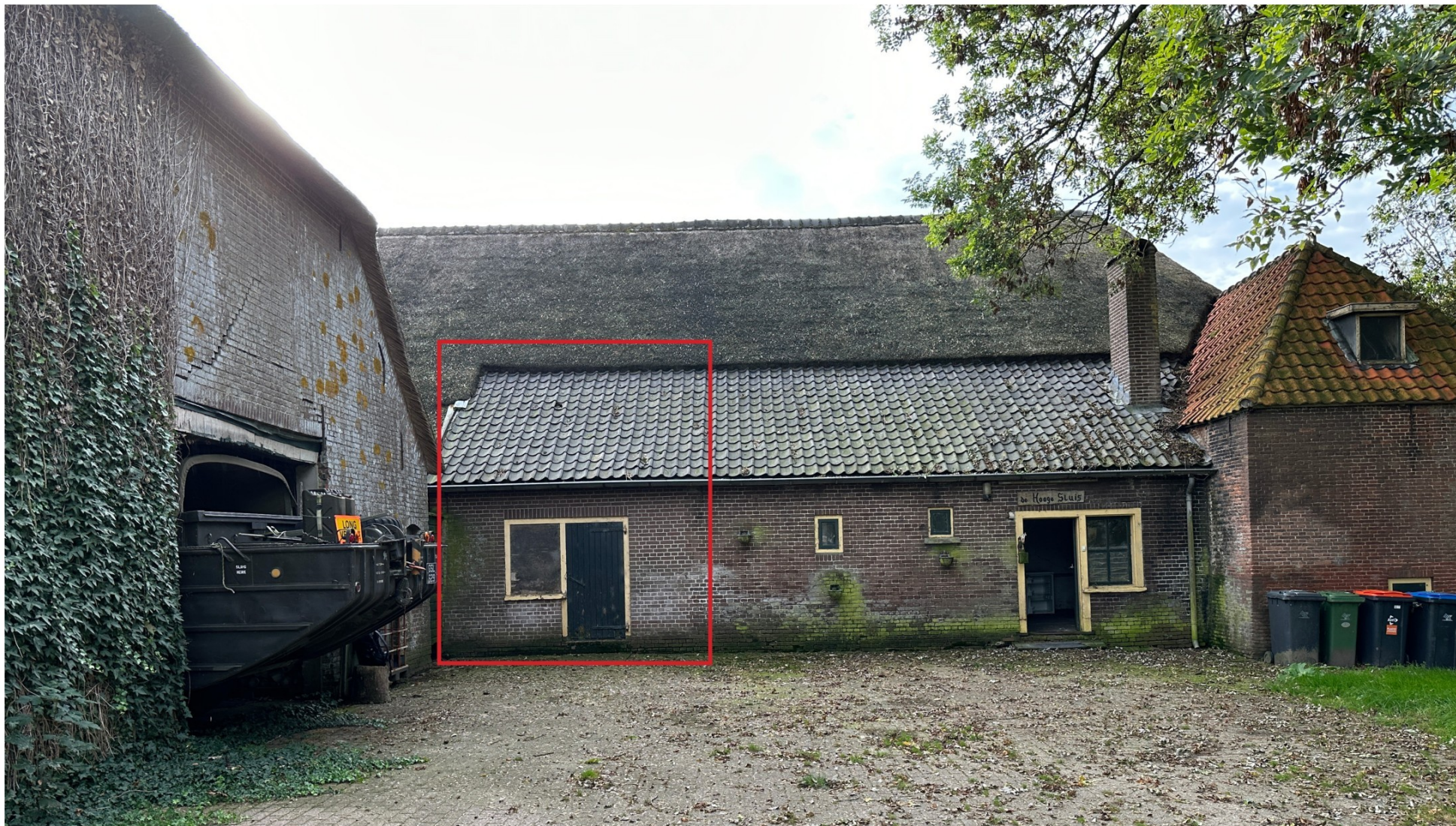
Afbeelding 50. Linker zijgevel van Stal 1 samen met voorgevel van Stal 2. De linker hoek van Schuur 1 werd veranderd volgens de geveltekeningen en plannen in 1983. Het rechtergedeelte van schuur 1, zou het oudste gedeelte van de gebouwen zijn. De voorgevel van Stal 2 is gewijzigd: de latei van de poort is vernieuwd en vertoont zware scheuren. Van de twee ramen die op de tekeningen staan, is er één niet meer aanwezig.
