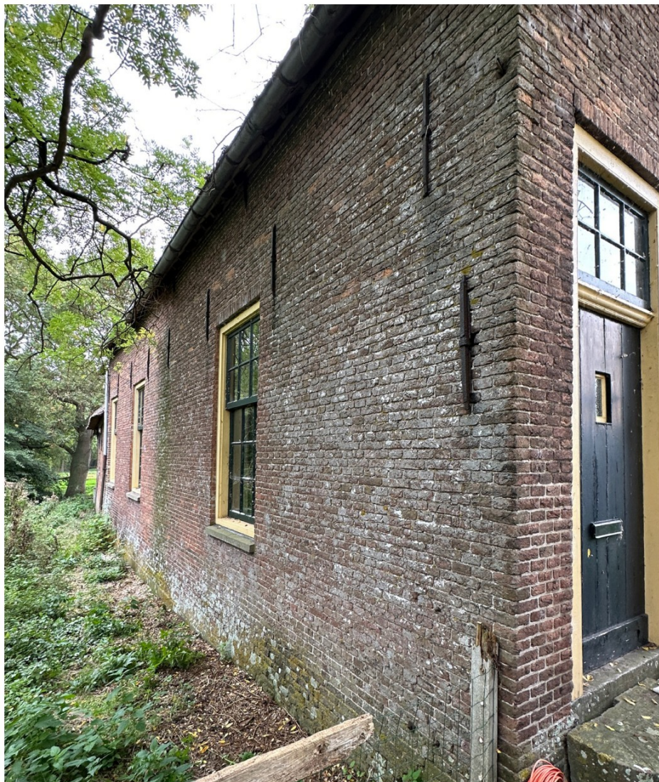
Afbeelding 59. In de voorgevel van de woning die langs de entreehal loopt zien we de grote raamopeningen, die in hun huidige grootte zeker niet origineel zijn. Rechts de overgang naar de entreegevel (Rechter zijgevel).
