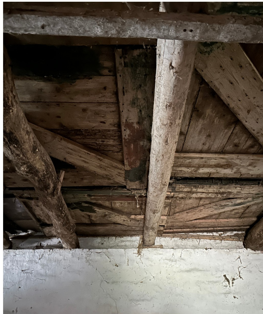
Afbeelding 71. Vloer van eerste verdieping in stal 2, bestaat uit houten poortdeuren. Deze liggen op houten balken die opgelegd zijn op de wanden van de stal.
