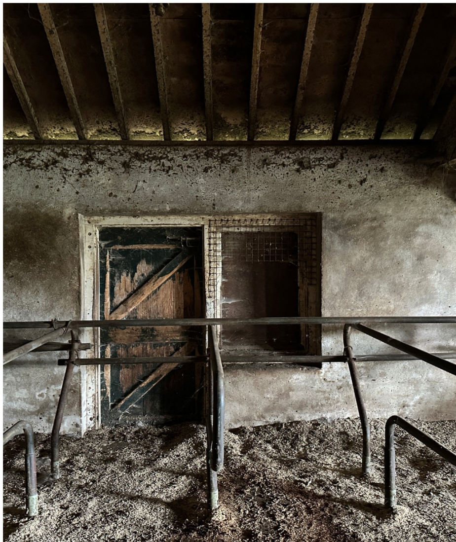
Afbeelding 66. Interieurbeeld van de linker zijgevel van Stal 1 die gewijzigd is in 1983. Deur K03.005. Er is een dikte verschil merkbaar tussen de bestaande muur en de nieuwe invulling.
