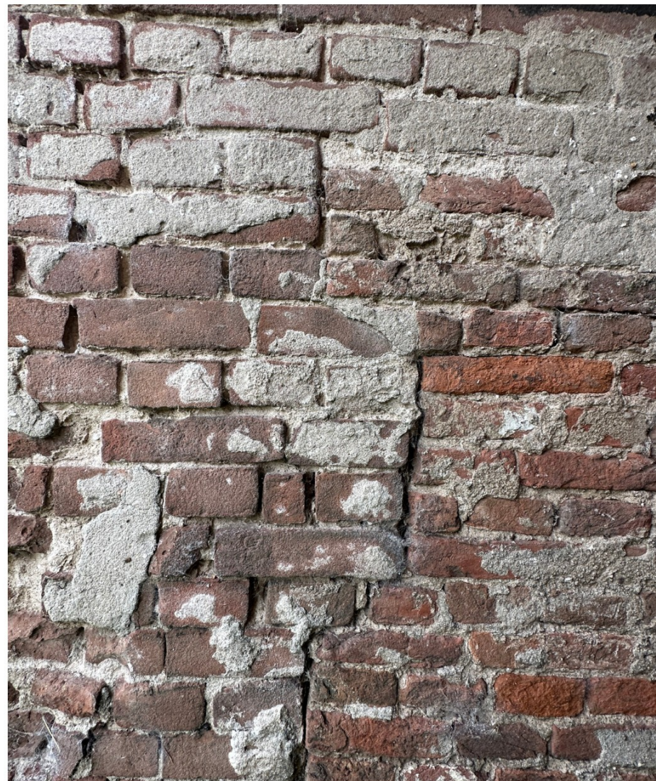
Afbeelding 42. Zijwand Stal 1 met duidelijk verschillende bakstenen, met een verscheidenheid aan afmetingen. Het oudste gedeelte van de wand dateert van 1802.
