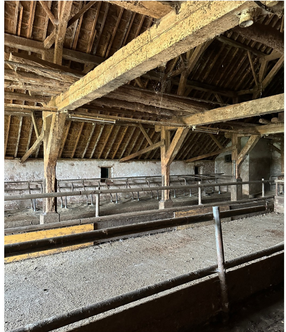
Afbeelding 65. De vloer en basis van de kolommen in de stal werden in 1983 gewijzigd om de koeienstal aan de nieuwste eisen te laten voldoen.
