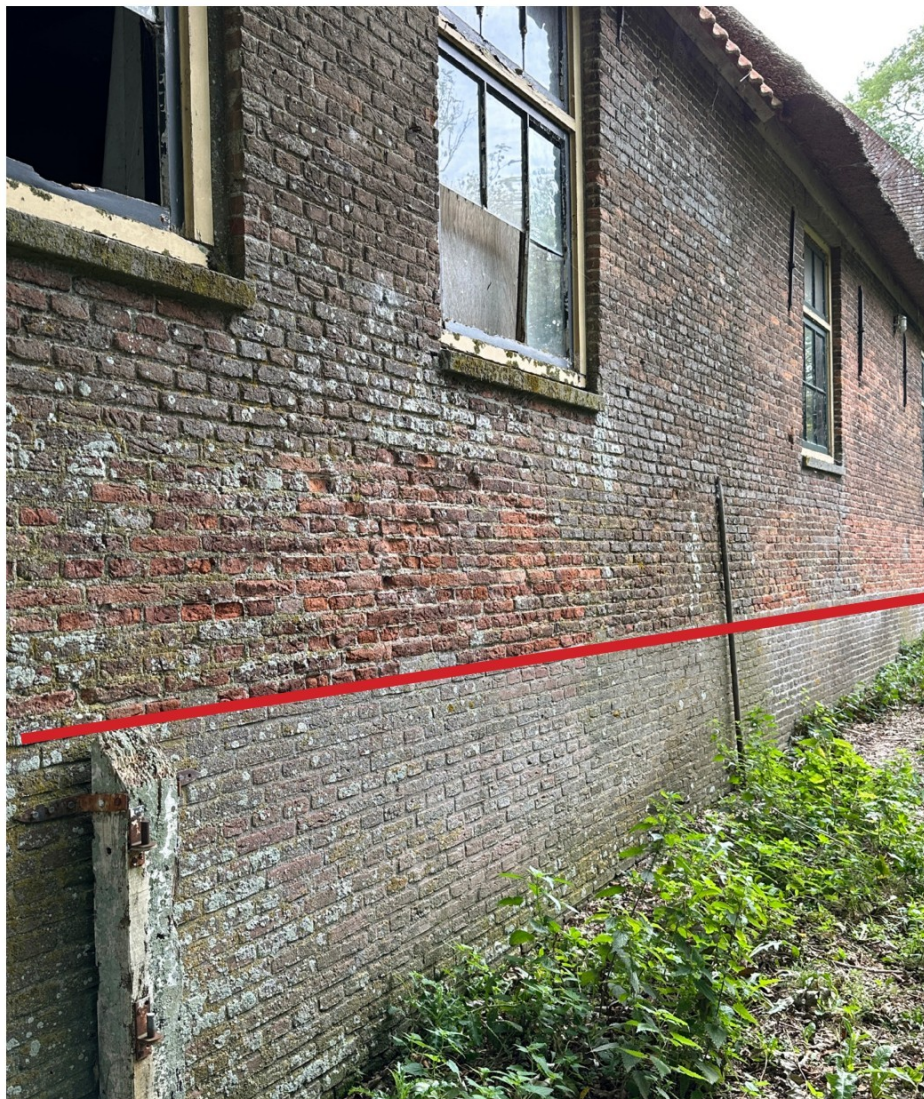
Afbeelding 55. Voorgevel van het woongedeelte in Stal. In 1947 werd een bouwvergunning opgesteld voor het vervangen van de basis van de wand. De effectieve uitvoering vond vermoedelijk pas plaats in 1983.
