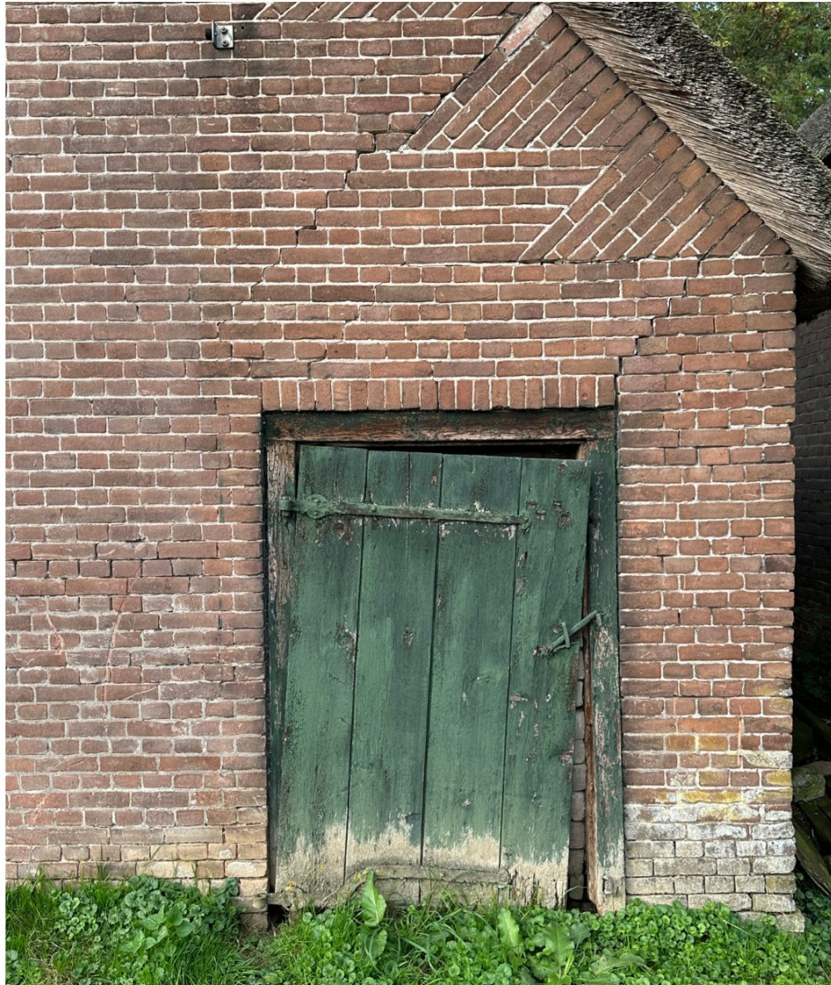
Afbeelding 46. Detail schuur 1. Deur in de rechterhoek, Rechter zijgevel Stal 1. De deuropening werd aan de binnenzijde dichtgemetseld in 1983.
