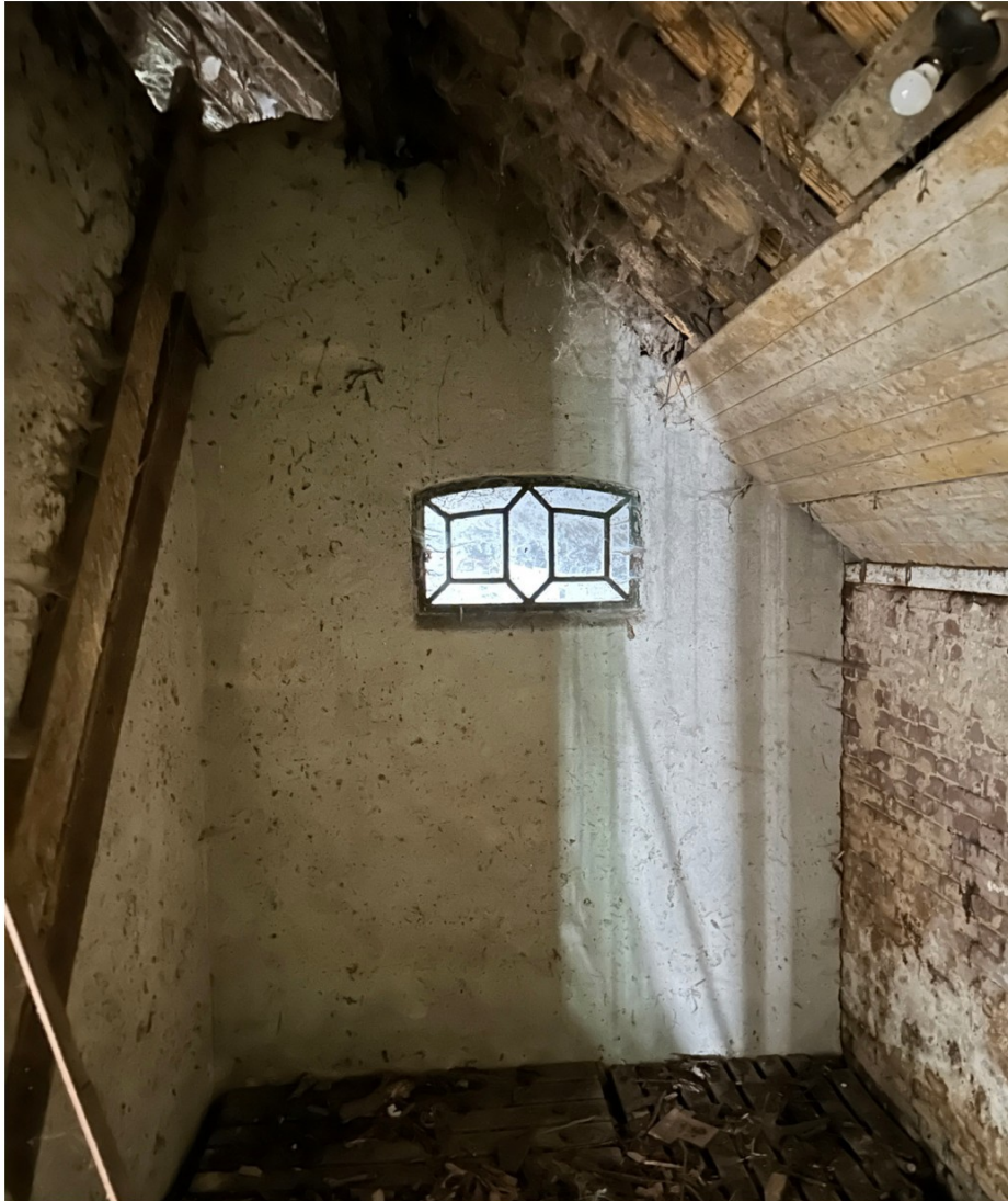
Afbeelding 80. Ruimte 0.11, het raampje geeft uit naar ruimte 0.15. Het ijzeren raam is gelijkaardig aan de ramen die in Ruimte 0.10 voorkomen. Deze wand is niet ingetekend in de plannen van 1983 dit zou een latere invulling kunnen zijn. Het zou ook deel kunnen zijn van de aanpassingen in 1983, toch lijkt de uitvoering eerder op een uitvoering voor 1983 te wijzen dan erna. Vermoedelijk zal deze situatie toch in 1983 zijn ontstaan.
