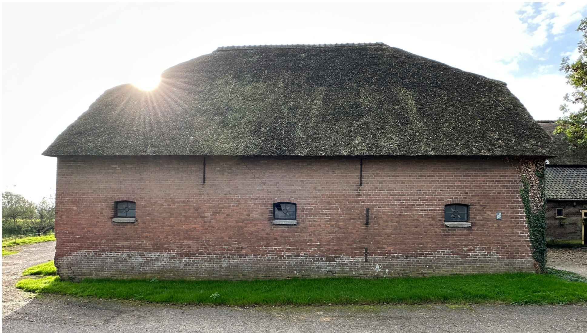
Afbeelding 49. Linker zijgevel van schuur 2, met originele stalen ramen, waterslagen uit gepleisterde baksteen. Deze ramen verschillen van de meeste ramen in de boerderij, aangezien ze van gietijzer zijn en niet van hout. De onderzijde van de wand vertoont zoutuitblaoi wat normaal is voor de functie van het gebouw.
