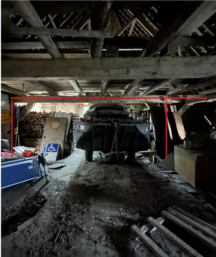
Afbeelding 68. Stal 2 met een asymmetrisch dakspant. De ruimte is opgesplitst in drie traveeën. De gebinttussenstijlen zijn verbonden aan de tussenbalk en gebintbalkschoor door pen- en gatverbindingen met houten nagels.
