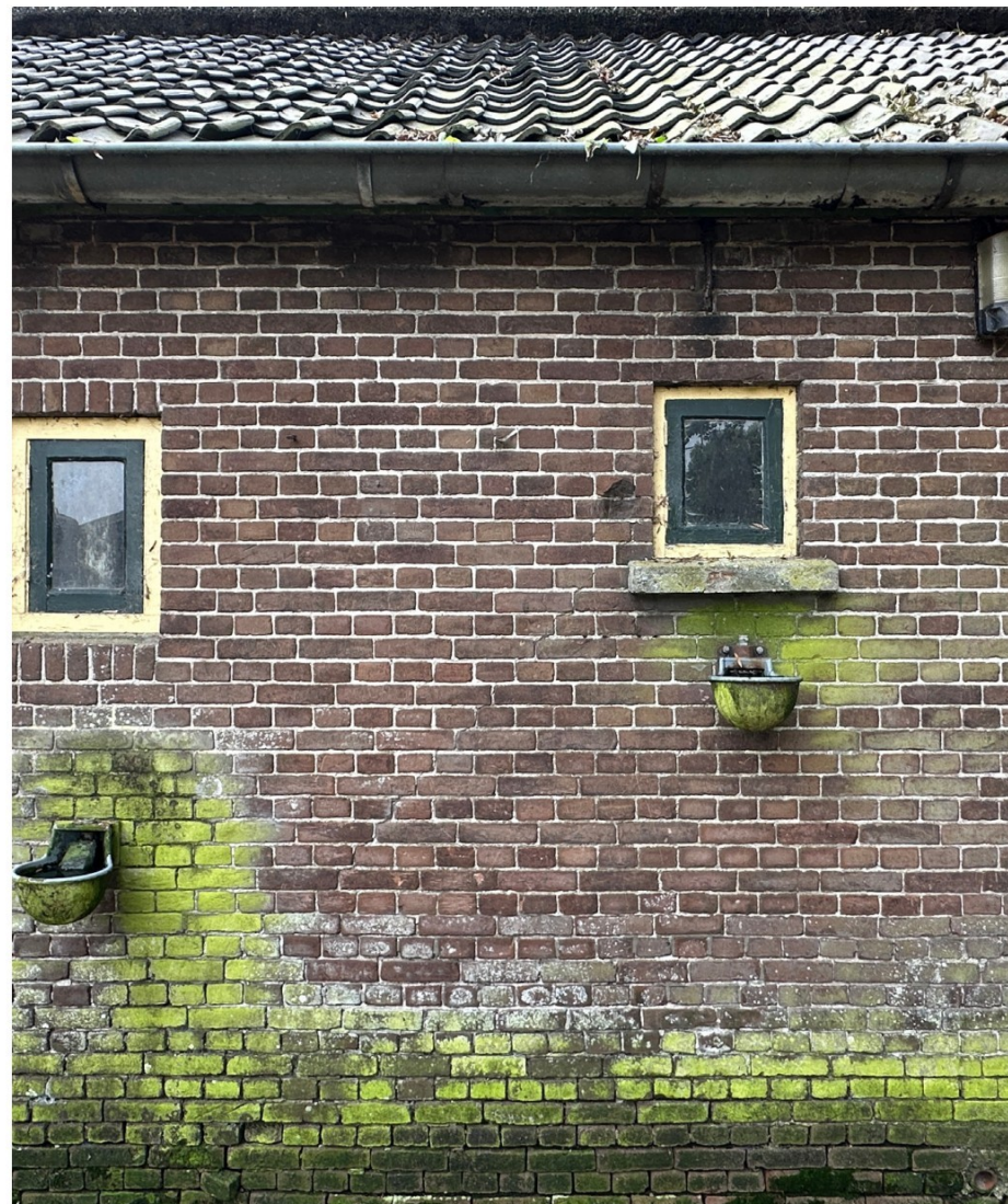
Afbeelding 52. Ramen in Achtergevel van Stal 1, Waar de twee ramen een verschillende vensterbank hebben, rechts K03.004 en links K03.003. Het linker venster is oorspronkelijk, het rechter is later ingebroken.
