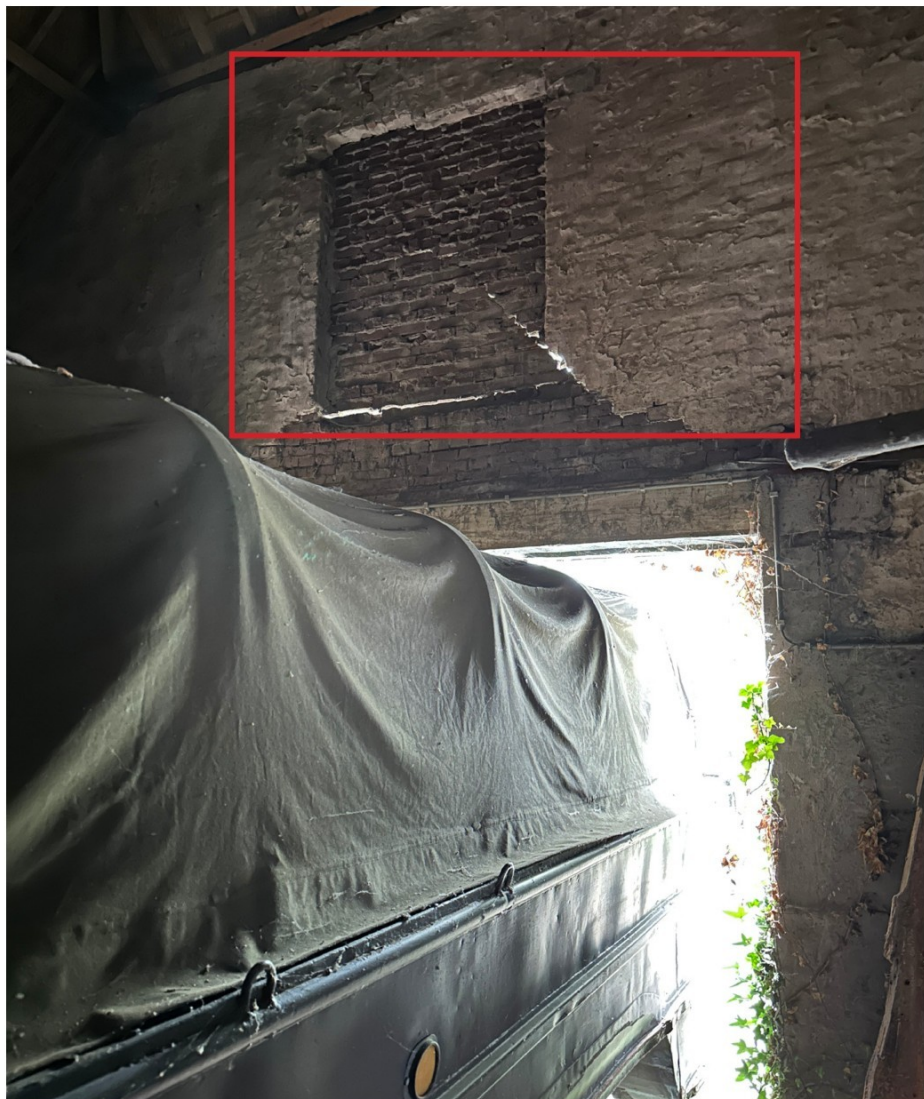
Afbeelding 70. Raamopening boven poort in Linker zijgevel van Stal 2 is dicht gemetseld. De deuropening werd ook vergroot waardoor er scheuren zijn ontstaan boven de latei.
