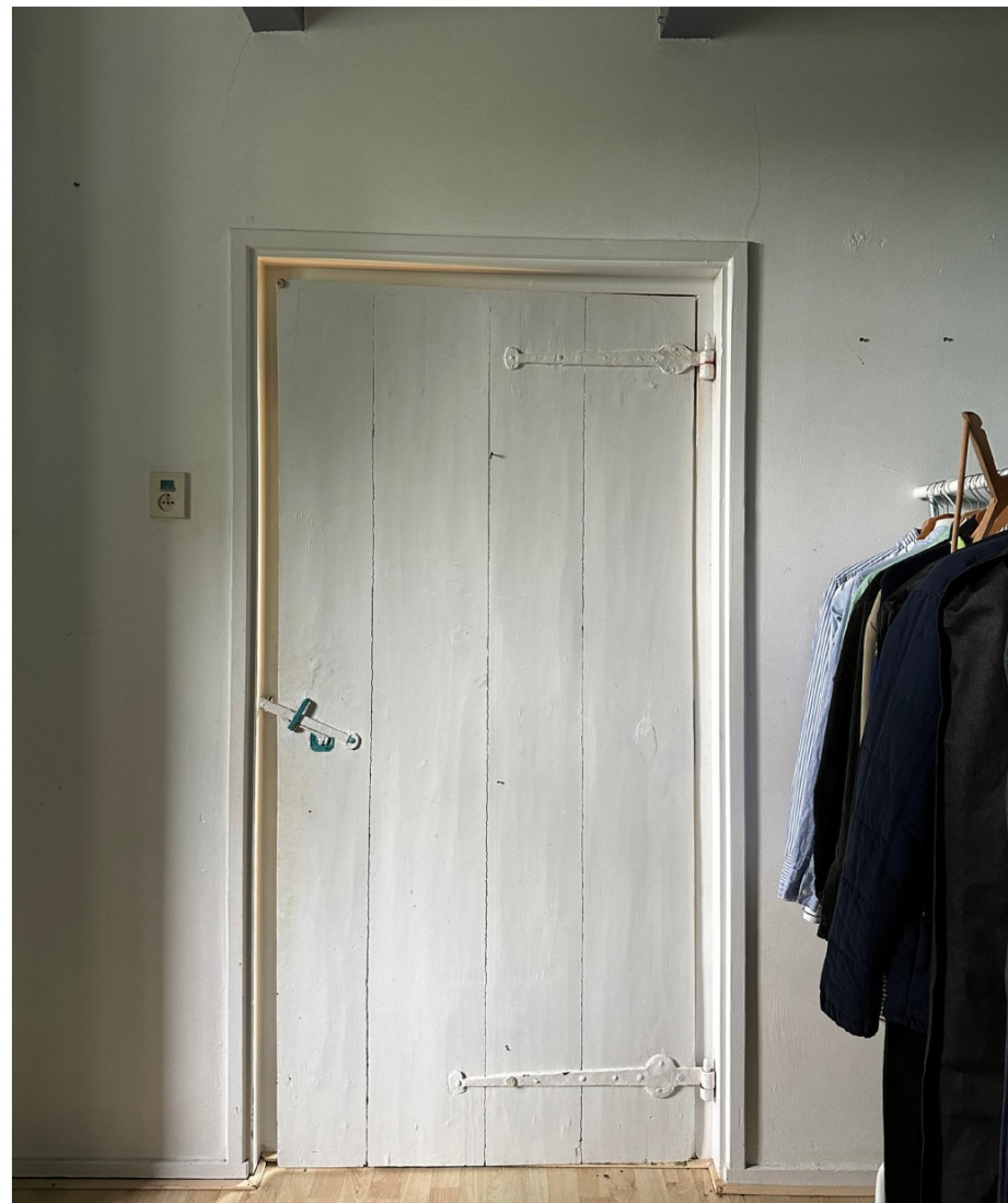
Afbeelding 91. Deur van ruimte 0.02 naar 0.01. Deze opgeklampte houten deur lijkt origineel te zijn (18e-eeuwse).
