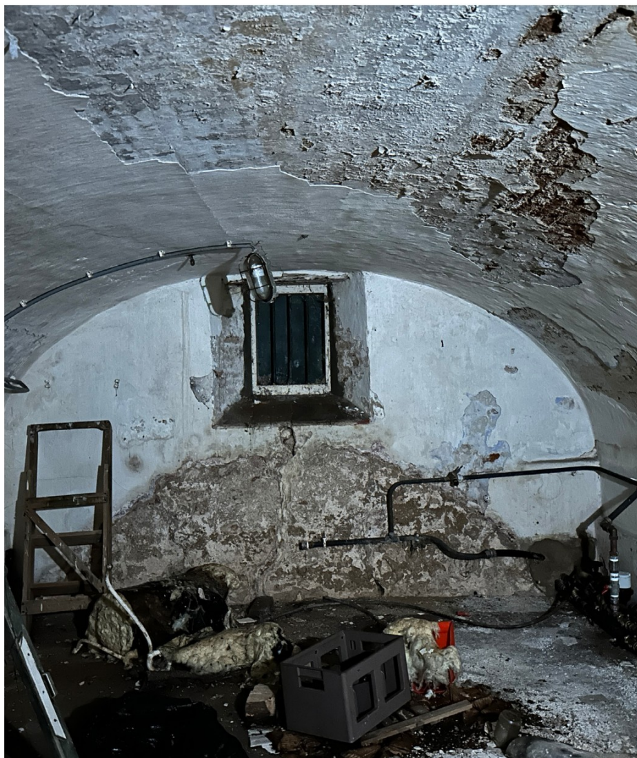
Afbeelding 36. Ruimte -0.1. Het gewelf bestaat uit een gepleisterd en geveerd metselwerk. Pleisterwerk en verflagen brokkelen af. De ruimte is toegankelijk met een trap. Er is een raam K03.001, dat zich in de achtergevel bevindt.
