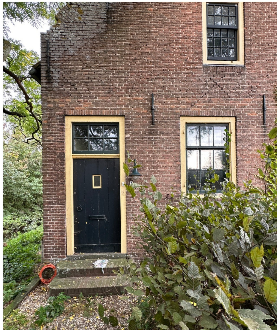
Afbeelding 60. Voordeur van de woning. Deze Rechter zijgevel is grotendeels onveranderd gebleven sinds de bouw in de 18e eeuw. Alleen de roeden van de ramen zijn nieuw en kloppen wat verhoudingen betreft ook niet helemaal.
