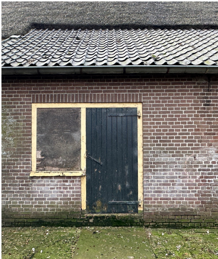
Afbeelding 51. Detail nieuwe deur in Linker zijgevel van Stal 1. De compositie van deur en raam is overgenomen van reeds bestaande deuren en ramen in de gevel, K03.002. Dit vond plaats in 1983.
