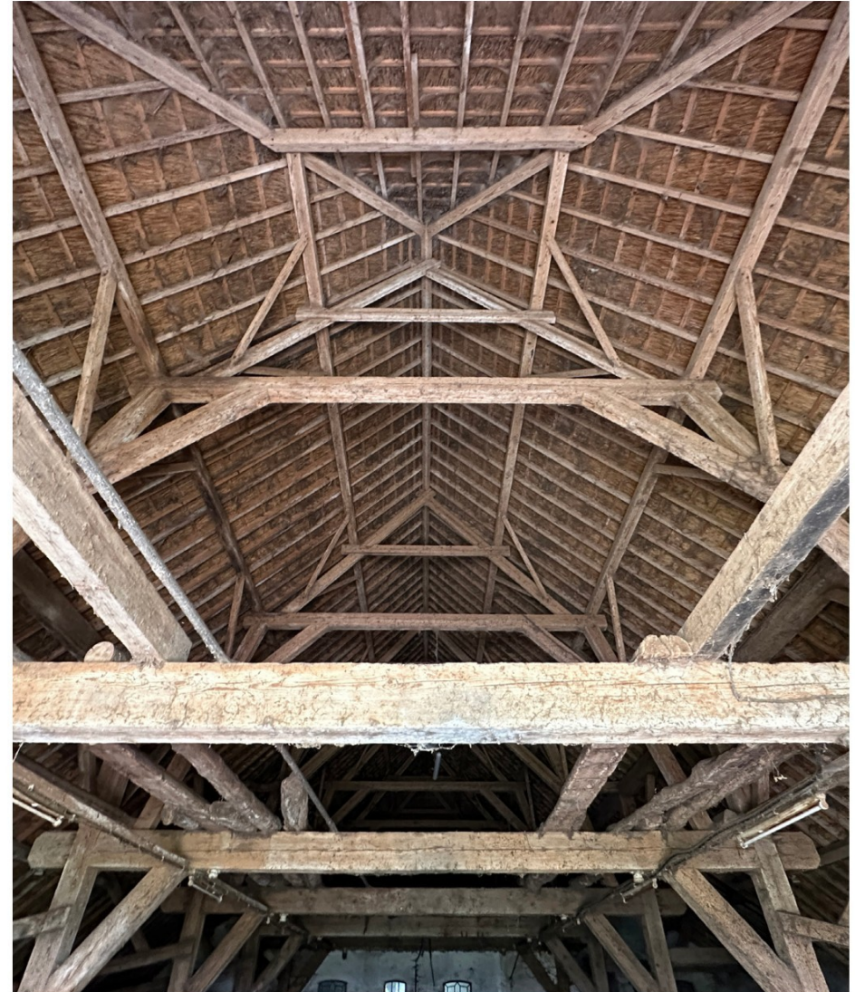
Afbeelding 63. Dakspant van Schuur 1, in goede staat. Ruimte 0.15. de indrukwekkende constructie dateert vermoedelijk uit de 19e eeuw, hoewel zelfs een 18e-eeuwse datering nog wel denkbaar is. De constructie is gaaf bewaard.
