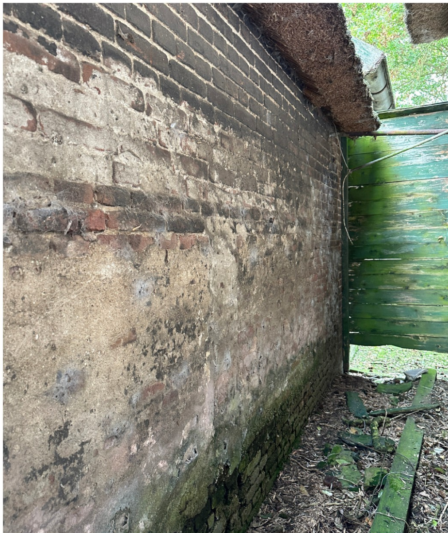
Afbeelding 41. Zijwand van Stal 1 in de gang tussen Stal 1 en 2, waar verschillende types baksteen zichtbaar zijn. Het blijkt dat het middelste gedeelte van de muur uit hergebruikt en oudere baksteen gemaakt is.
