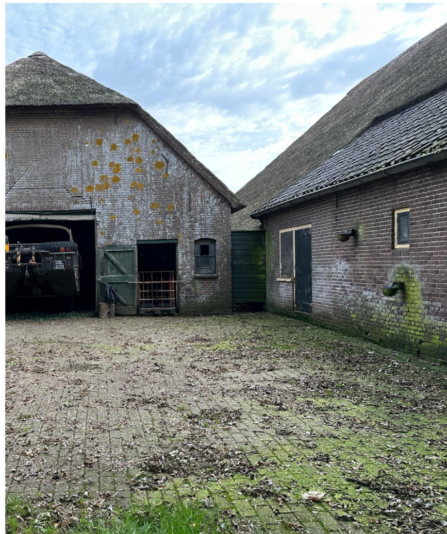
Afbeelding 54. Verbinding tussen stal 1 en stal 2, waar een houten wand de gang tussen de twee gebouwen afsluit.
