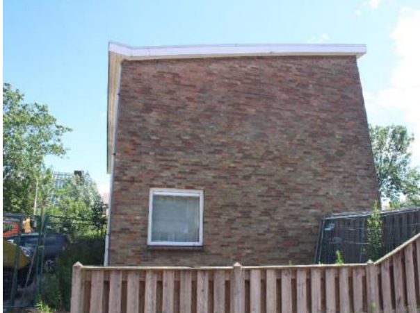
Afbeelding 20 en 21: Zijaanzicht woning met open stootvoegen.
