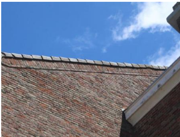
Afbeelding 27 en 28: Kantpannen van de ontmoetingskerk en open eind nokvorst.
