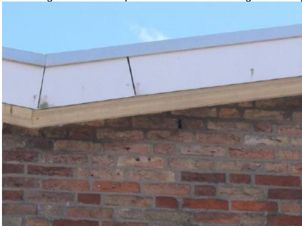
Afbeelding 29 en 30: Open stootvoegen in de bebouwing naast de kerk.
