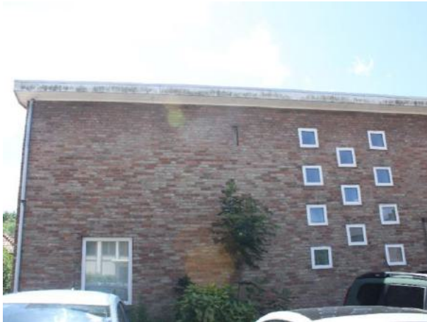
Afbeelding 18 en 19: Vooraanzicht woning met open stootvoegen.
