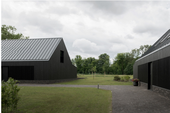
Eenvoudig, sober bijgebouw van één laag met kap met donkergrijze, zwarte houten rabat bekleding en zwart zinken dak (Bron: [redacted])
