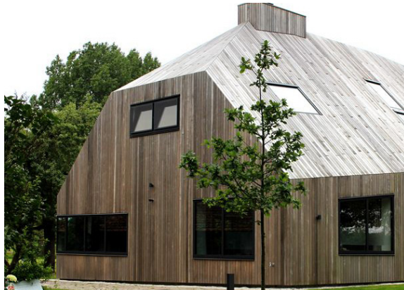
Hoofdgebouw één bouwlaag met kap en wolfseind-dak in houten rabatdelen (Bron: Platowood)
