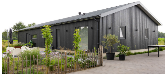
Eenvoudig, sober bijgebouw van één laag met kap met donkergrijze, zwarte houten bekleding en zwart zinken dak. De materialisatie van de buitenzijde van de bijgebouwen moet volledig doorlopen zijn, zonder onderbreking in de gevelbekleding tussen de units. (Bron: [redacted])
