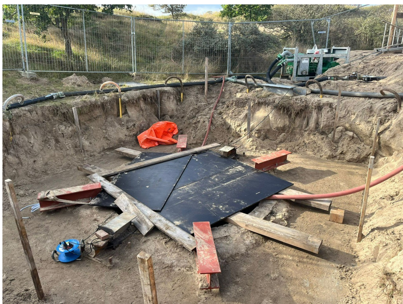
Figuur 8-1 Voorbeeld filterbemaling (in dit geval bij schacht winning 9.1)
