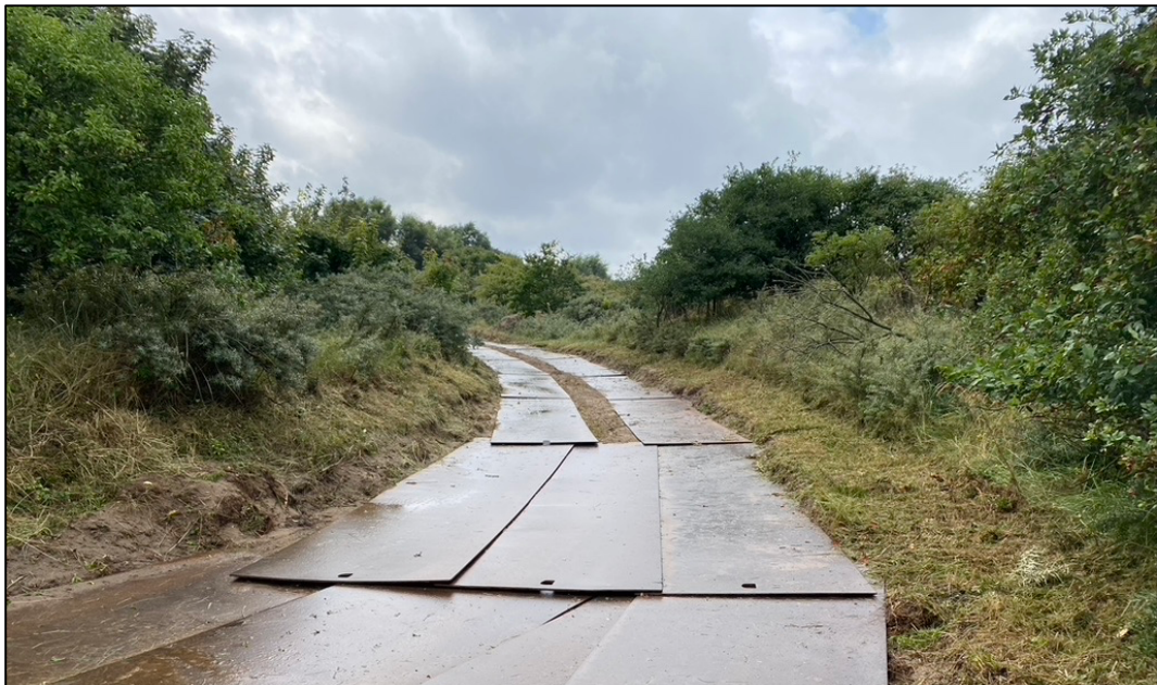
Figuur 2.5 Tijdelijke werkwegen en werkwegen over bestaande onderhoudspaden worden voorzien van rijplaten die na afloop van het werk weer worden verwijderd. De rijplaten voorkomen insporing en beschermen de bodem.
