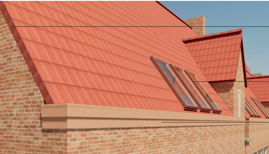
Gedetailleerde dakrand in kleur van het metselwerk en dakramen in kleur OVH-pannen
