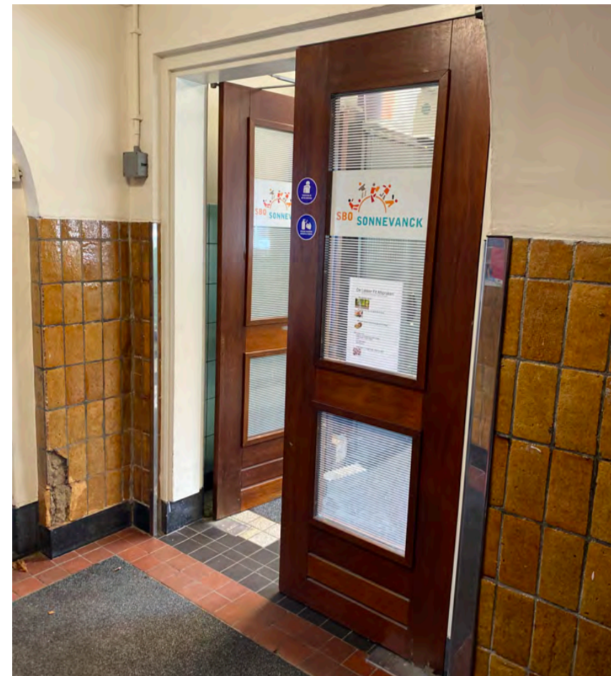
Brandwerende pui (foto huidige toestand)
