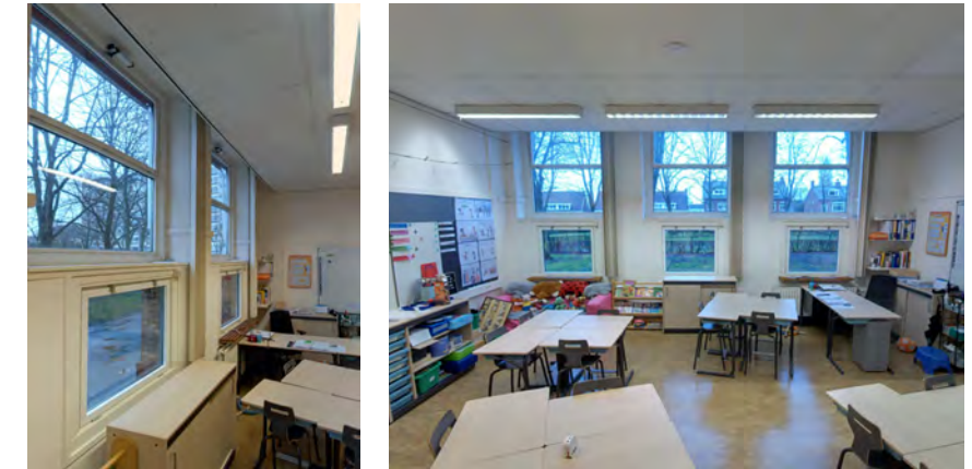
huidige toestand (2024) verlaagd plafond lokalen
