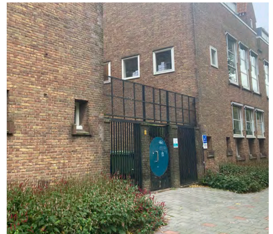
Zwartewaalstraat entree naar fietsenberging en binnenplaats SBO Sonnevand en OBS Globe
