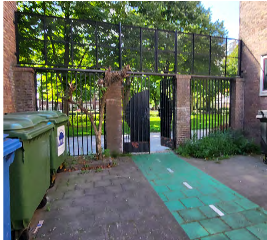
Hekwerk entree fietsenstalling en binnenterrein
