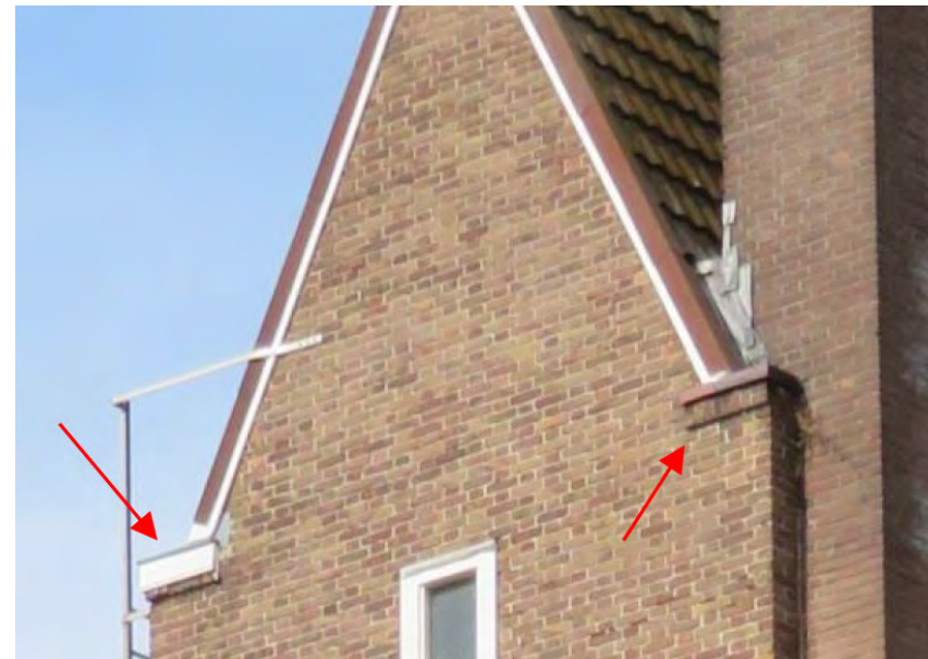
Toren Zwartewaalstraat 28 huidige toestand, links het witte grenen geprofileerde boeiboord en rechts het oorspronkelijke detail met de sprong in het metselwerk en de afdekking van hardgebakken plavuizen. De metselwerk rand onder de plavuizen lijkt alleen op de koppen te zijn toegepast.
