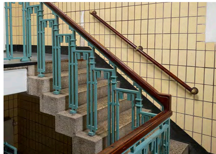
Trappenhuis Zwartewaalstraat 28 (foto huidige toestand)
