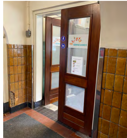
Later toegevoegde brandwerende puien (foto huidige toestand)
