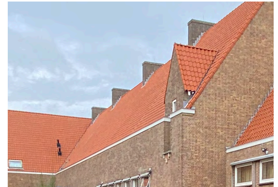
Dakrand huidige toestand met witte boeiboorden die integraal zijn toegepast.
