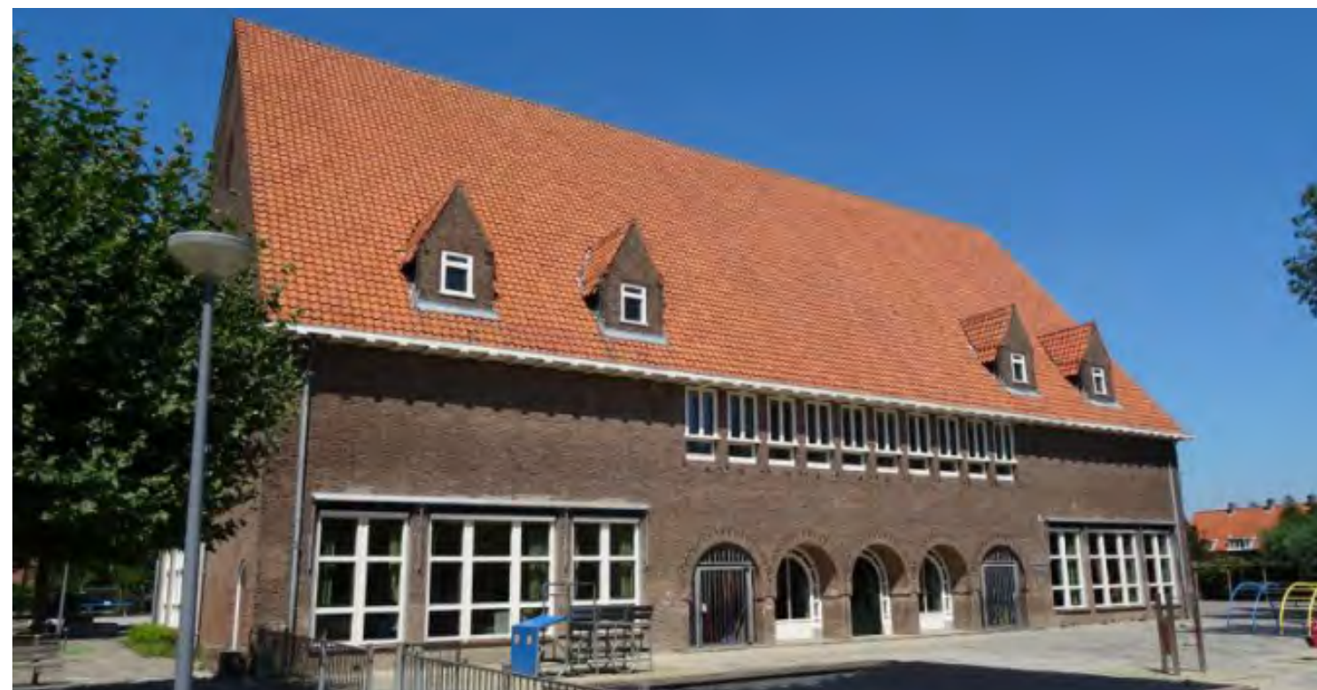
Bewaarschool en bibliotheek de Mare. Ramen onder de dakrand volgen het ritme van de gevel.
