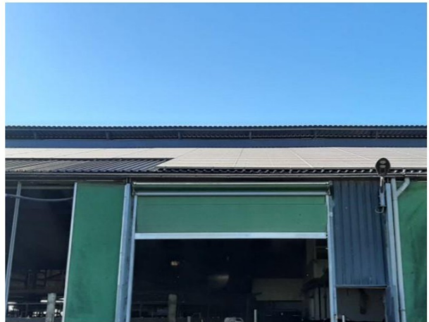
Figuur 14 Dak van de stal met zonnepanelen en damwandplaten
