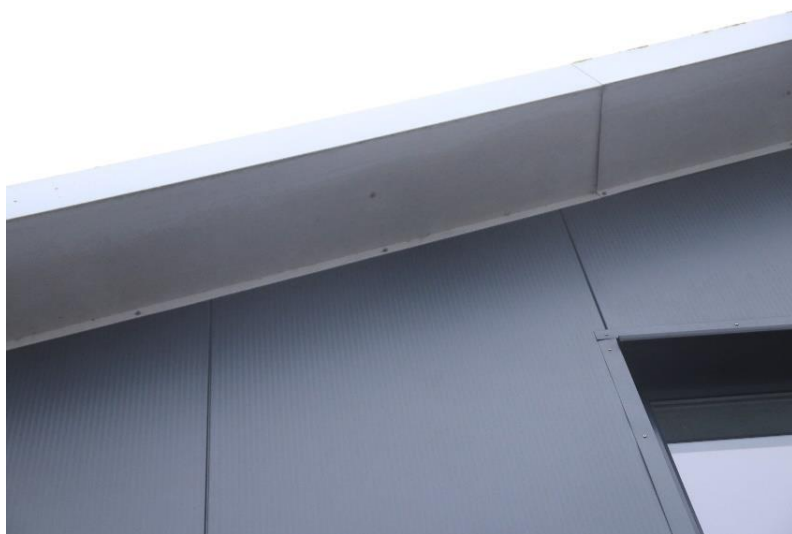
Foto 1: De overgangen van de muur naar de dakconstructie zijn strak afgewerkt. Er zijn nergens openingen aanwezig.
