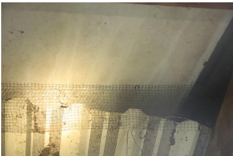
Foto 3: Gaas zorgt ervoor dat vleermuizen en broedvogels geen toegang hebben
