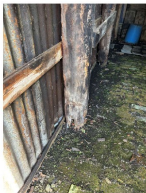
Balken zijn aangetast en doorgerot
