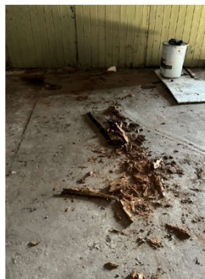
Aangetast hout van het dak ligt op de vloer
