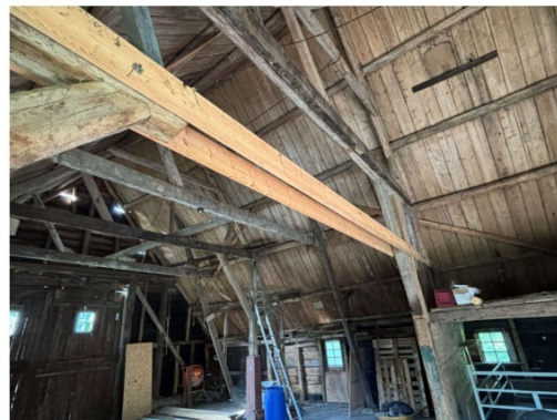
Balken uit de hoofddraagconstructie zijn verwijderd
