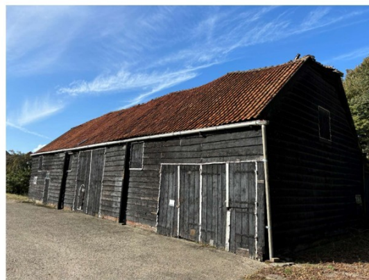
Dak verzakt en goten beschadigd
