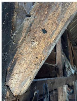
Houtworm aangetroffen in de kapconstructie
