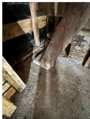
Houtworm aantasting bij constructie
