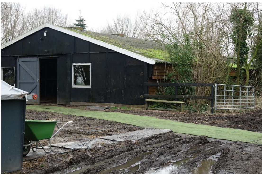
Figuur 5. Voormalige kippenstal niet toegankelijk voor vleermuizen, door aansluitende betimmeringen en struweel langs de zijgevels met lage goothoogte.
