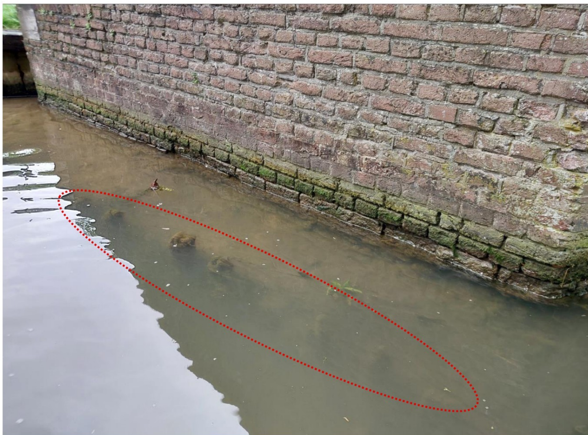
Figuur 6.1: Perkoenpalen onder water
