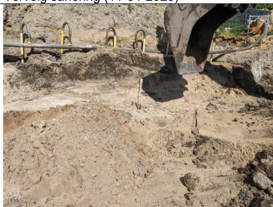
Vervolg na aanbrengen bronnering (23-05-2023)
