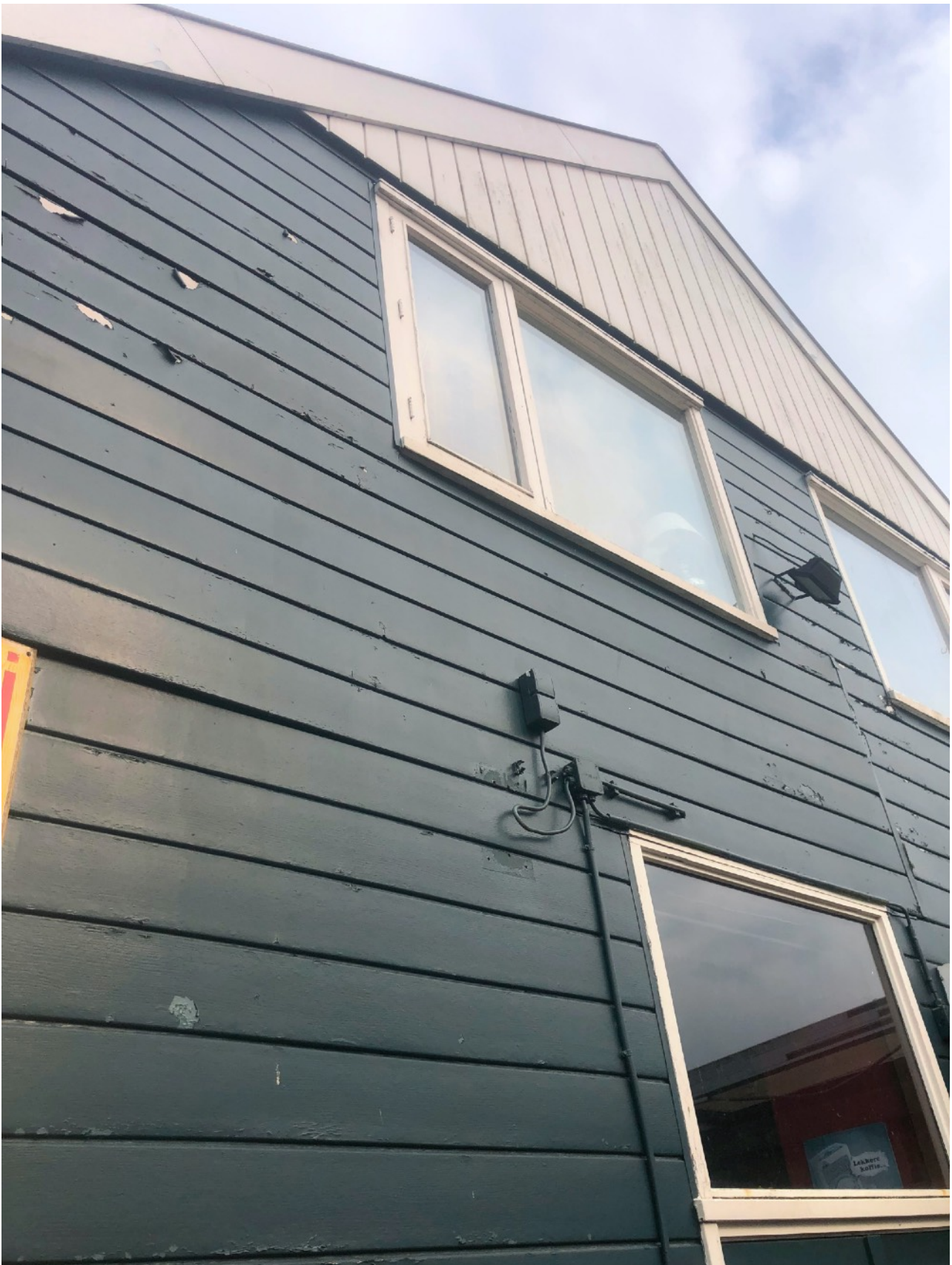
Afb.3: Deel van de gevel waar de gevelbekleding ruimte laat voor vleermuizen en hun verblijfplaatsen.
