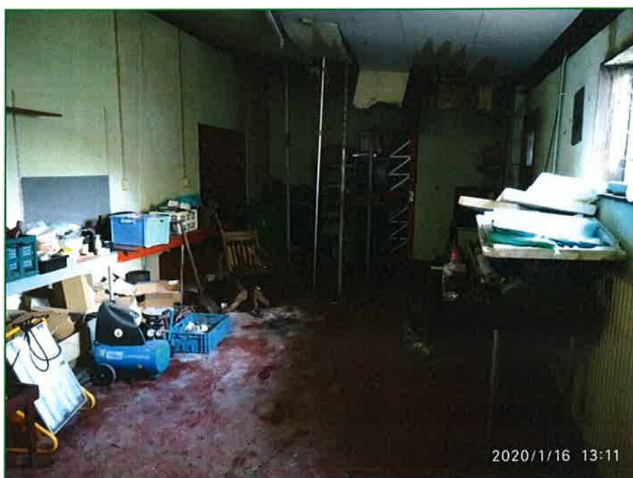
Foto 4. Ruimte voormalige drukkerij met intacte, gecoate betonvloer
