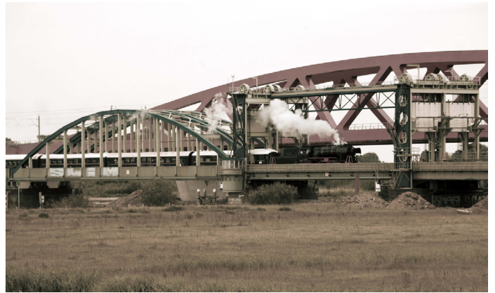
De Hanzeboog i.r.t. de oude spoorbrug (2011)
