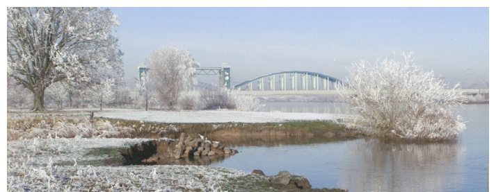
Oude spoorbrug zicht vanaf IJsselstein
