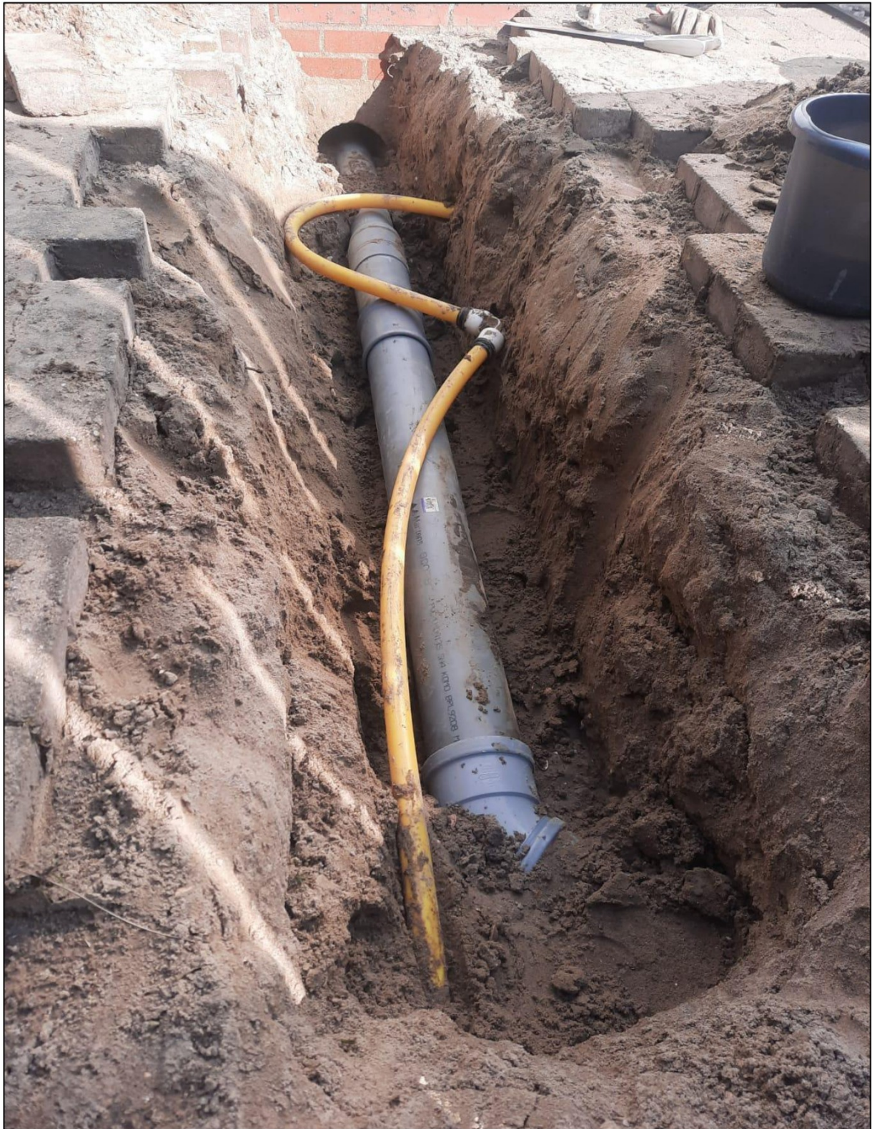
Figuur 15: Foto bestaand tracé water en gas (foto's zijn genomen naar aanleiding van een rioolverstopping die in het verleden heeft plaatsgevonden; bron opdrachtgever).
