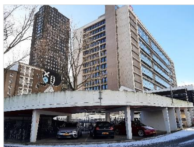
Figuur 2.6. De fietsenstalling in het westen van de onderzoekslocatie.
