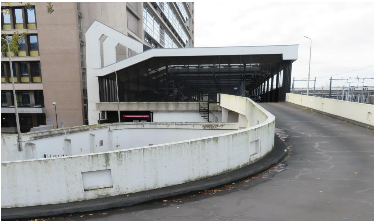
Zicht op de oprit naar het perron
