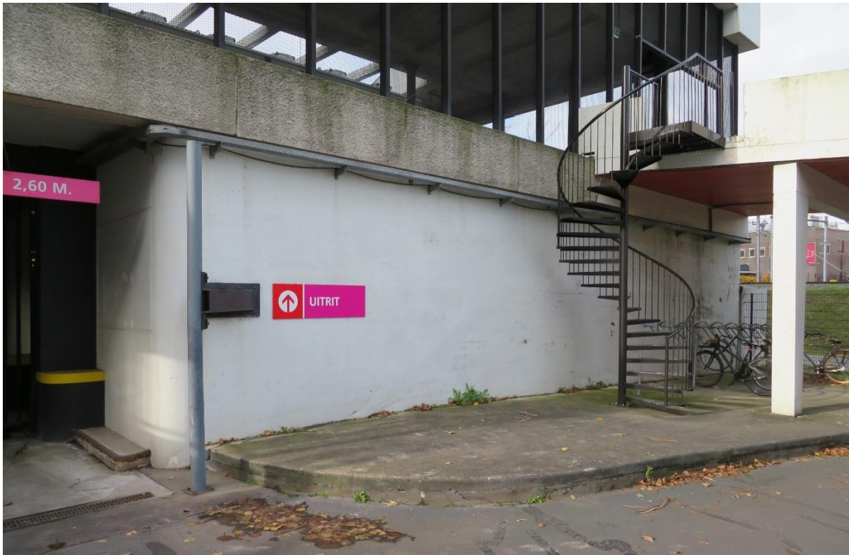
Links: Oostelijke wand van het perron, met wenteltrap vanaf het lage deel van de oprit naar het hoge deel
