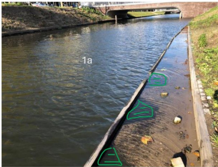
Foto: locatie damwand binnenstadzijde
