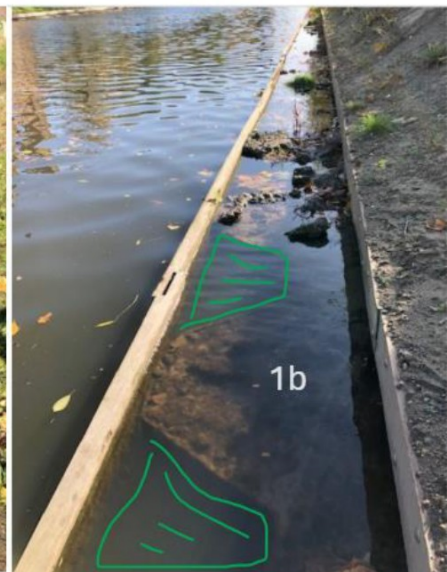
Foto: detail damwand Catharijnesingel buitenzijde
