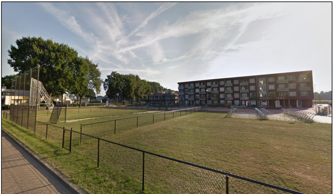
Projectlocatie gezien vanaf Zandkuilweg nabij tandartspraktijk
