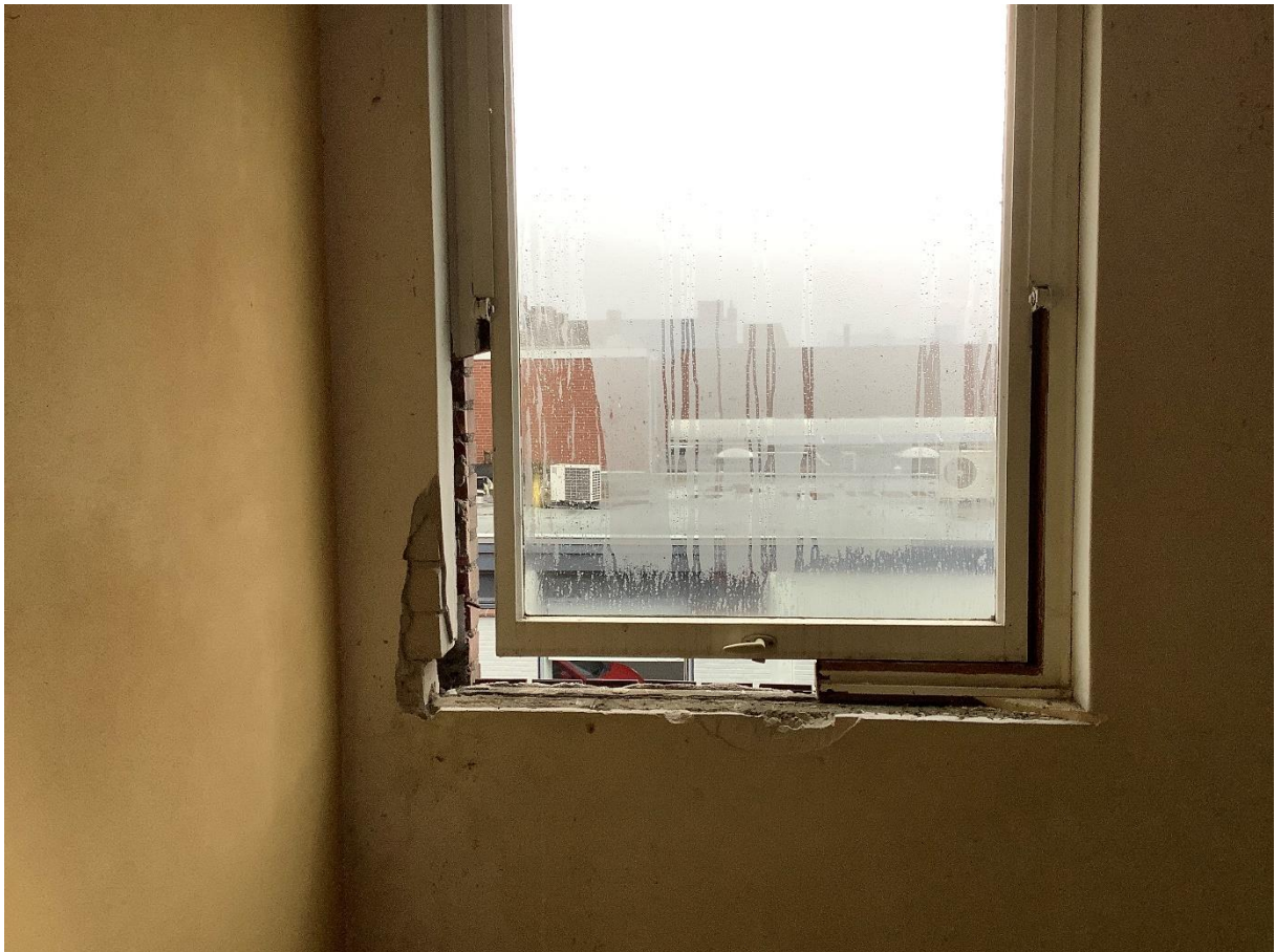
Foto 7: Het raam in de noordgevel waarvan een gedeelte van het kozijn mist.
