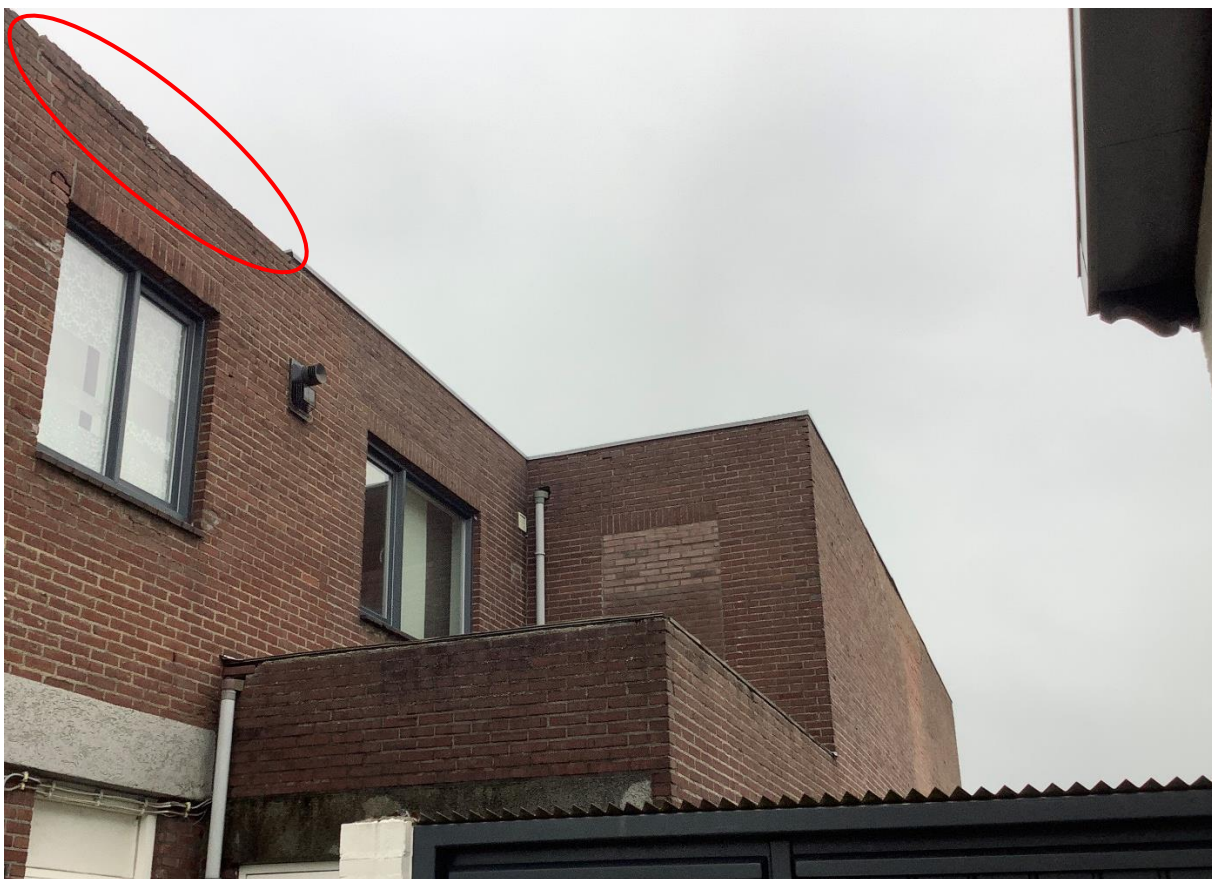
Foto 3: De zuidgevel van het pand met een deel van de missende daktrim rood gearceerd.
