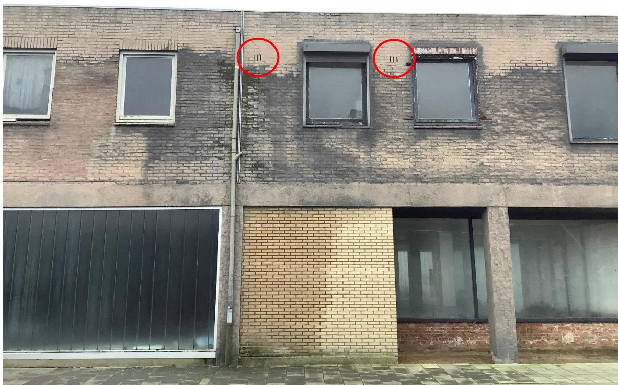
Foto 5: De open stootvoegen (rood gearceerd) in de noordgevel van het pand.
