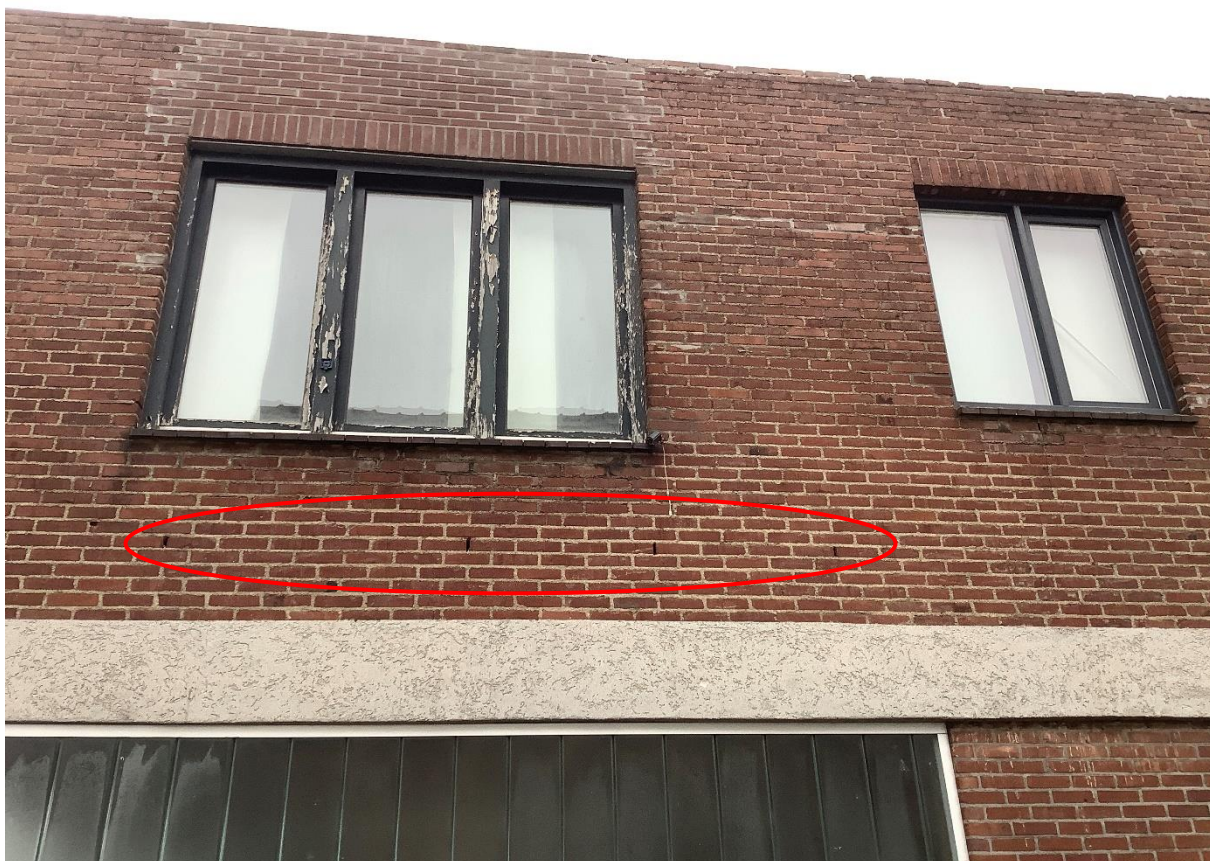
Foto 4: Impressie van de open stootvoegen (rood gearceerd) in de zuidgevel van het pand.
