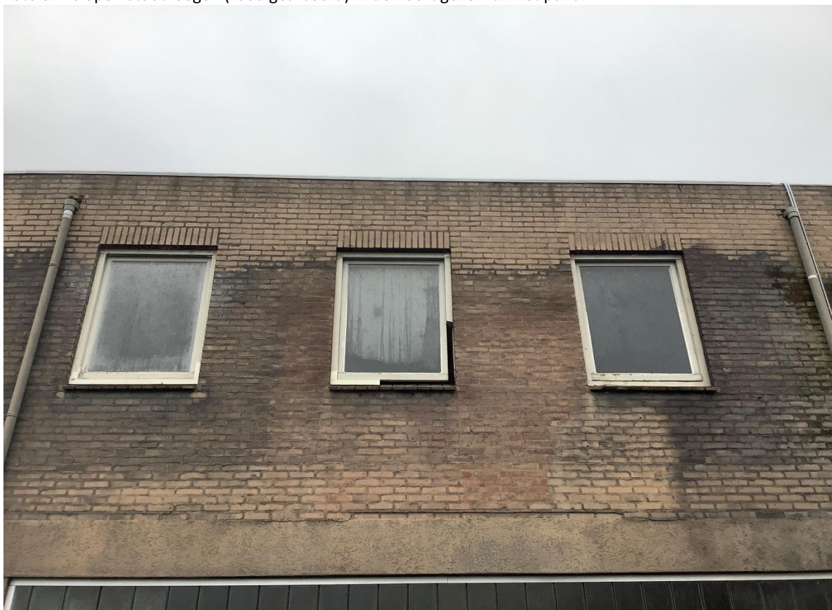
Foto 6: Het raam in de noordgevel waarvan een gedeelte van het kozijn mist
