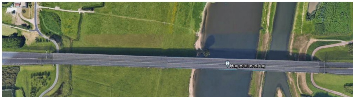
Figuur 2: Overzicht van bestaande Hagesteinsebrug
