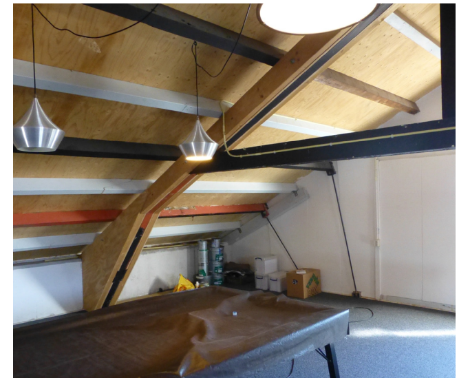
45. Zolder met dakconstructie middengedeelte
