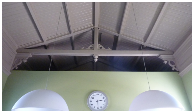
38. Interieur zijvleugel. Bij de verbouwing tot kantoorruimte zijn de dakspanten weer zichtbaar gemaakt.
