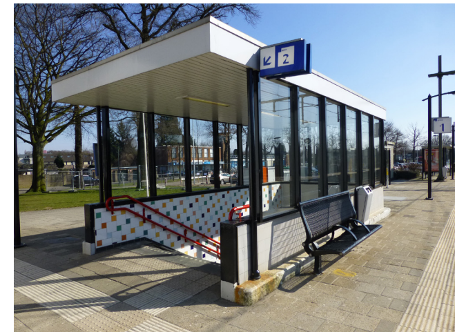
54. Huidige situatie entree voetgangerstunnel.
