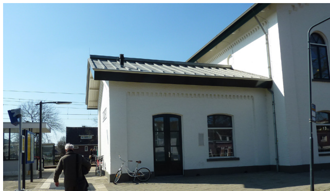
35. Gevel zuidvleugel, voorzijde. Het linkerraam is in de jaren tachtig vervangen door een deur.
