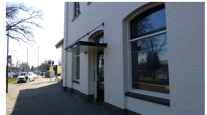
40. Gevel middengedeelte, voorzijde. De luifel is in de jaren zeventig aangebracht. STEENHUISMEURS 39
