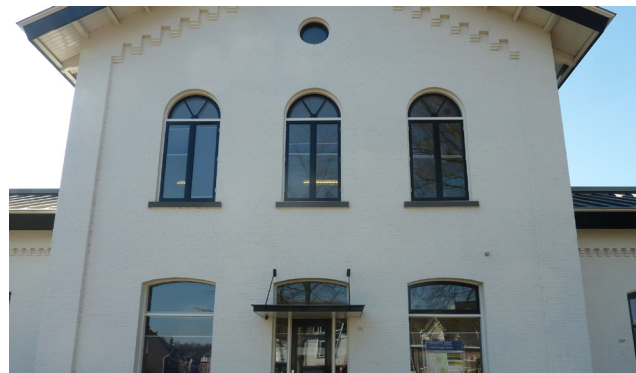
36. Voorgevel middengedeelte. Het station is in de jaren zestig wit geverfd. De kozijnen op de eerste verdieping zijn waarschijnlijk oorspronkelijk.
