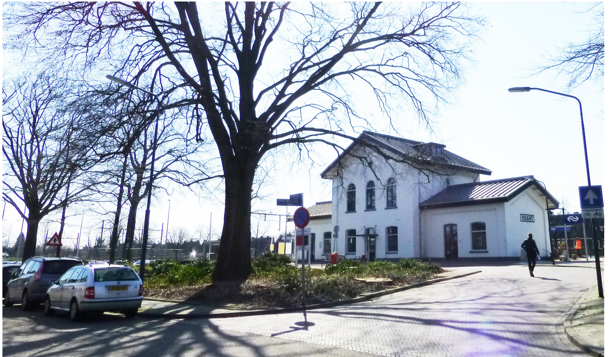
33. Huidige situatie stationsplein, 2013.
