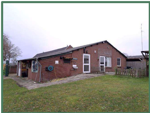
Foto 3: Te behouden bebouwing
