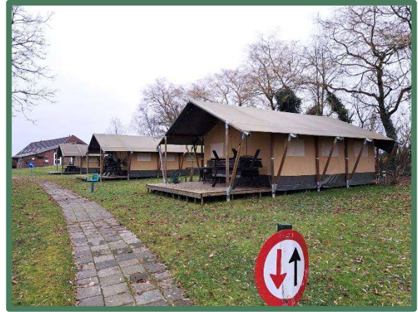
Foto 12: Te verwijderen houten/tentdoek chalets
