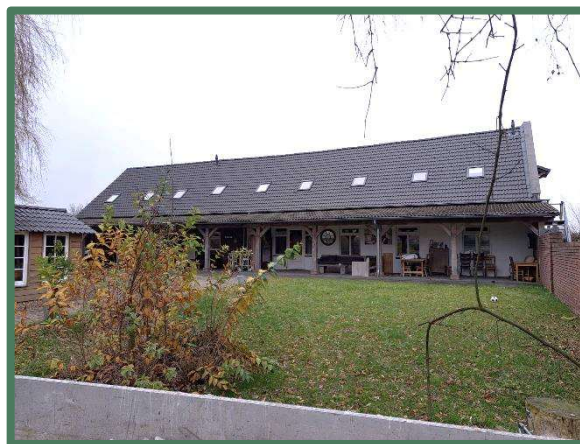
Foto 2: Te behouden bebouwing
