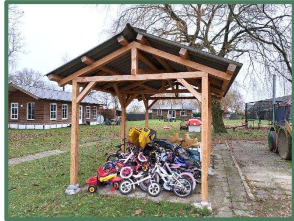
Foto 16: Te verwijderen overkapping
