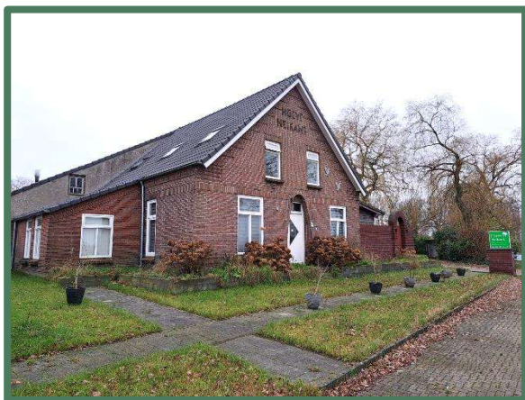
Foto 1: Te behouden bebouwing
