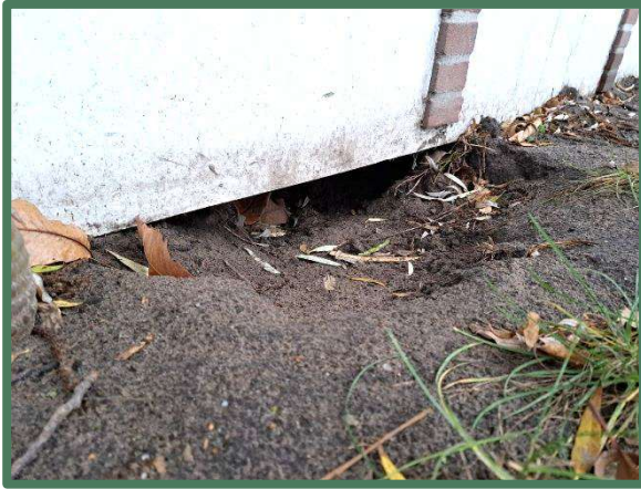
Foto 11: Toegang tot ruimte onder chalet
