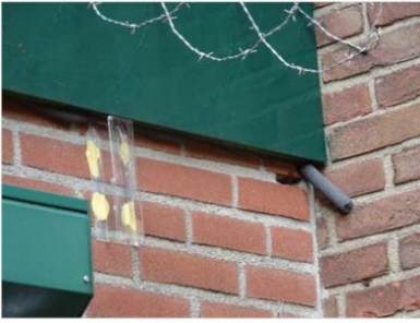
Figuur 5.3 Dakrand dichtgemaakt met vulschuim en exclusion flap.
