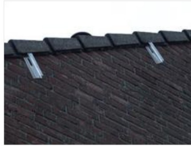
Figuur 5.4 Dakrand dichtgemaakt met vulschuim en exclusion flap.
