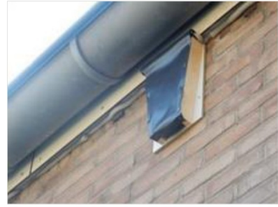
Figuur 5.5 Dakrand dichtgemaakt met latten, vulschuim en exclusion flap.
