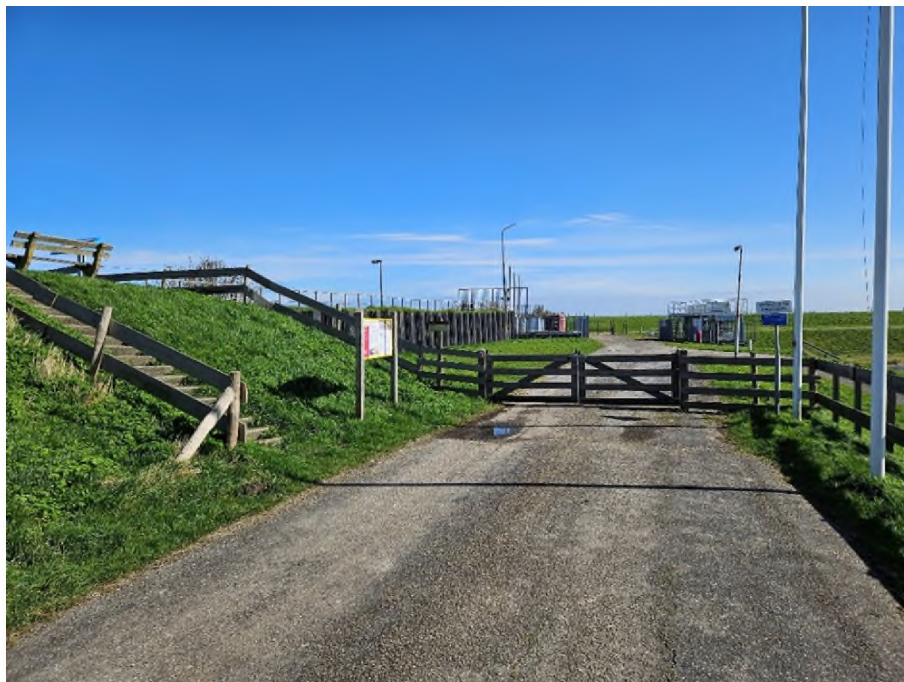
Figuur 2.2 Terrein van de spuisluis vanaf de Oostoeverweg
