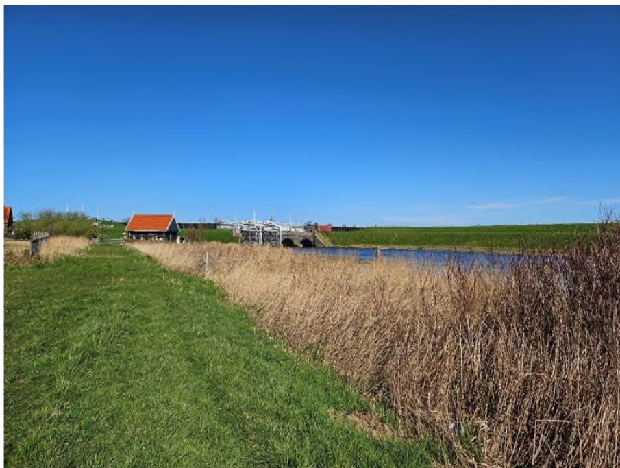
Figuur 2.6 Zuidelijk deel van het plangebied met zicht op de bestaande spuisluis
