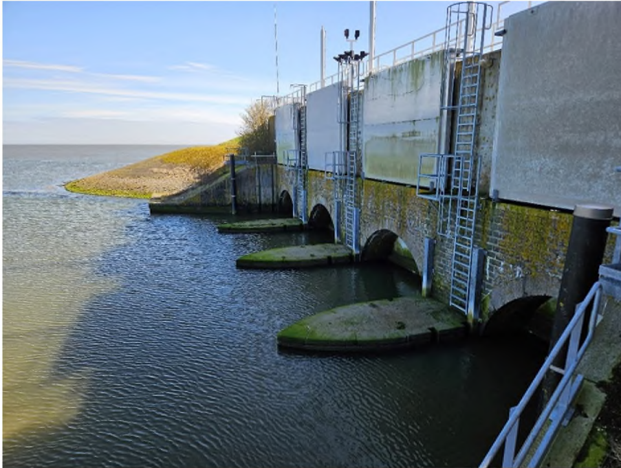
Figuur 2.3 De noordzijde van de spuisluis
