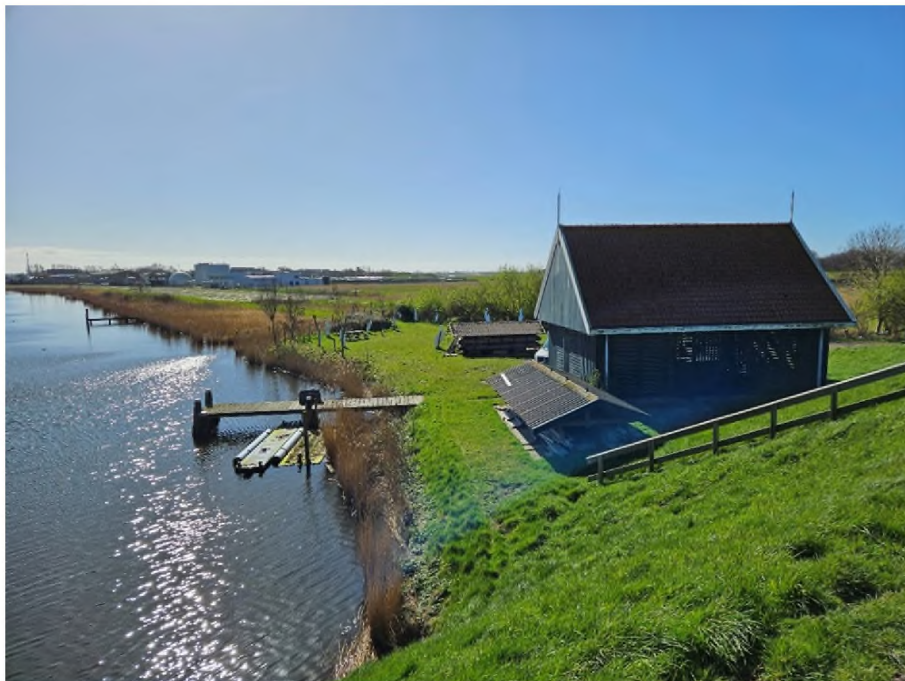
Figuur 2.8 De opslagschuur en links het Balgzandkanaal ten zuiden van de spuisluis
