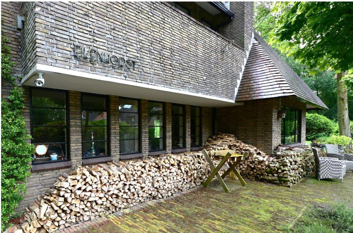
Het balkon rust op een dunne plaat gewapend beton.
