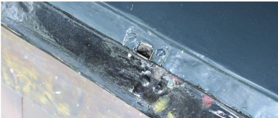
De onderdorpel van het kozijn laat de sluitkom van de oorspronkelijke espagnoletsluiting zien.
