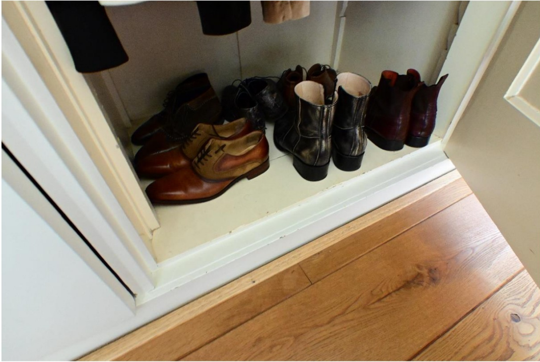
Het rechter kastdeel heeft nog de oorspronkelijke houten kastbodem, in het linker kastdeel is een moderne houten vloer gelegd.
