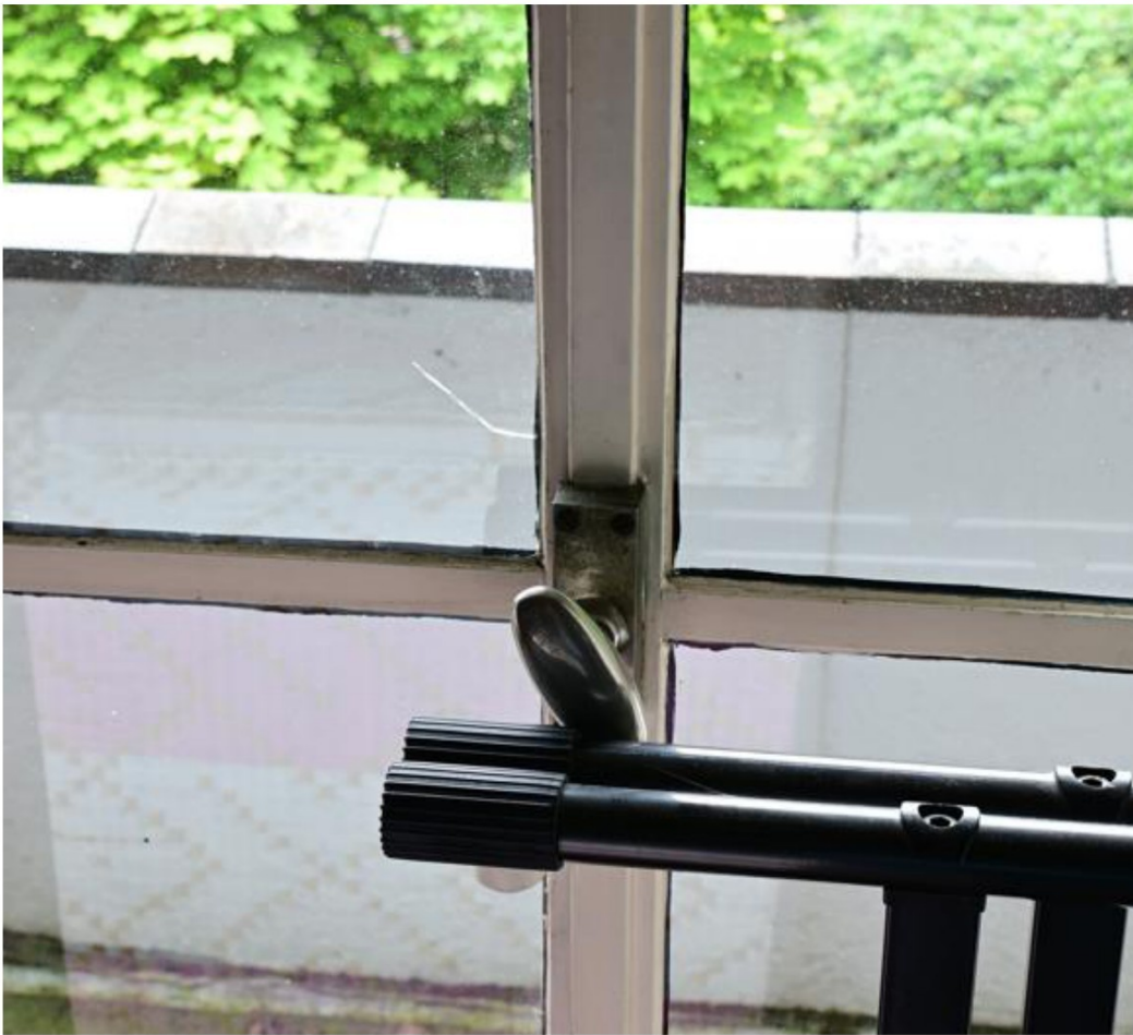
Detail van de originele draaiklink van de espagnoetsluiting.
