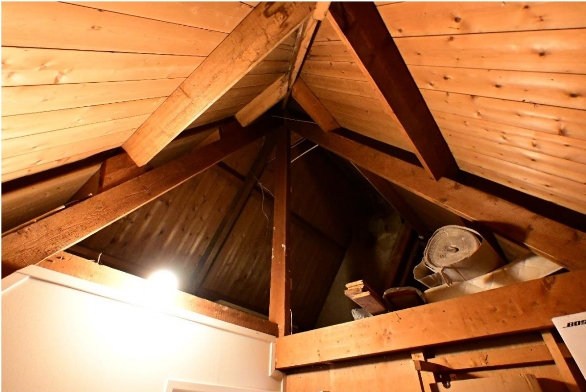
Blik in de kap vanuit de berging op de tweede verdieping. Alleen hier is de constructie zichtbaar. Vier gordingen dragen op deze verdieping het dakbeschoot.
