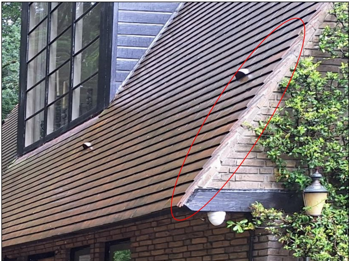
Detailfoto waarbij zichtbaar is dat gevelpannen naadloos op het metselwerk aansluiten en delen van het dak niet kieren.
