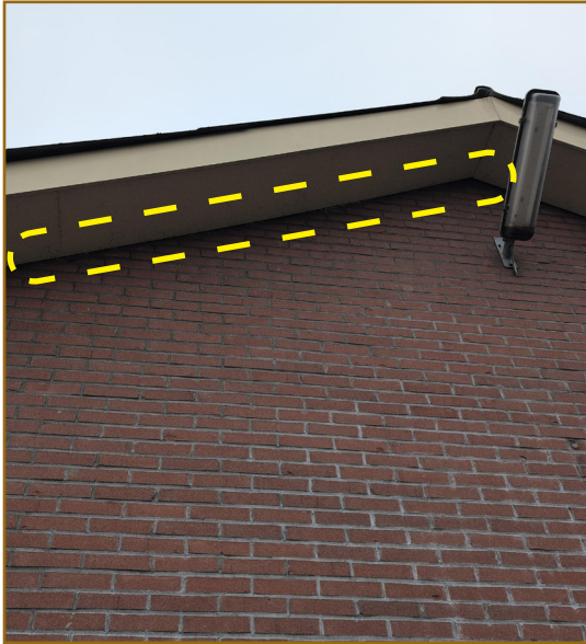
Afbeelding 1.3: Zuidelijke gevel van de te slopen bebouwing. Onder de overstekken en via de open stootvoegen kunnen vleermuizen naar binnen.
